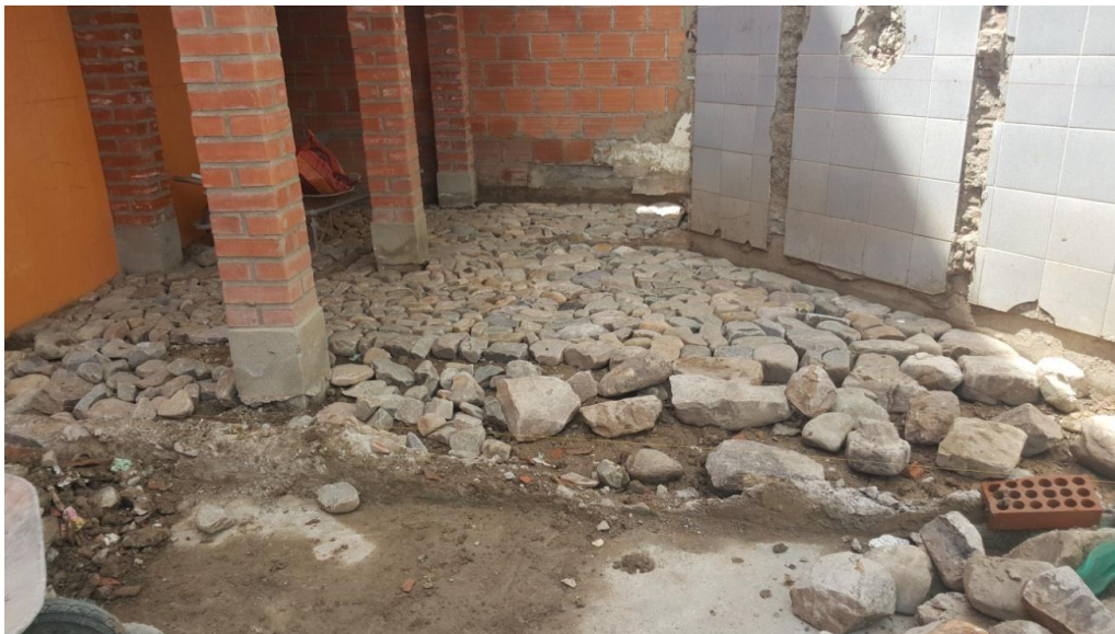
IMAGEN 1: DEMOLICION PISO DE CEMENTO + EMPEDRADO
