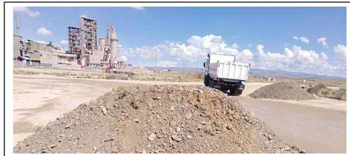
IMAGEN 1: ACAMELLONADO DE RIPIO
