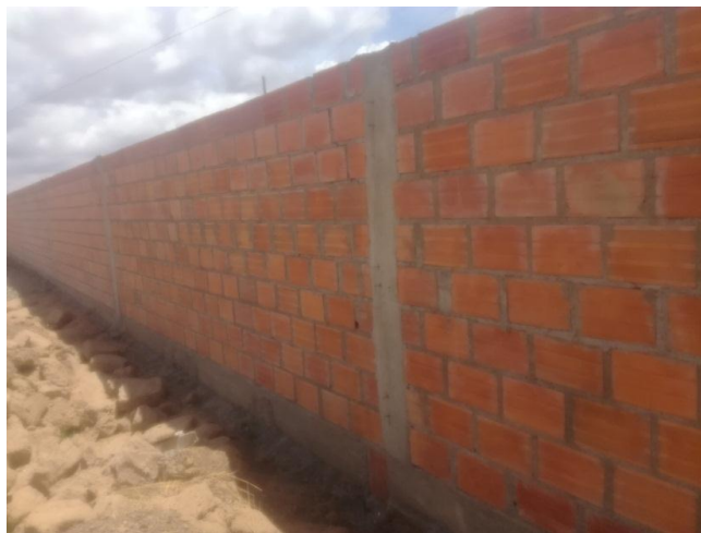
IMAGEN 1: CONSTRUCCION MURO PERIMETRAL U.E. JOSE BALLIVIAN DE HICHURAYA
