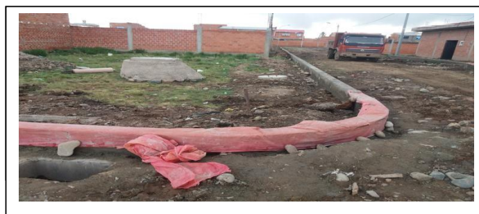
IMAGEN 3: CORDON DE ACERA CONCLUIDO
