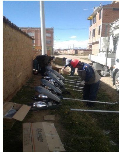
ARMADO DE LUMINARIAS Y COLOCADOS
