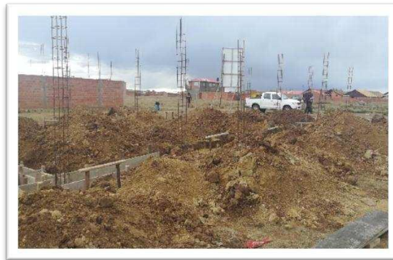
IMAGEN 1: COLUMNAS DE HORMIGÓN ARMADO
