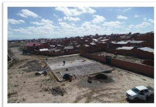
IMAGEN 2: PISO DE CEMENTO RESISTENCIA 210 S/EMPEDRADO
