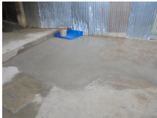
Fuente: Archivo Dirección de Infraestructura
