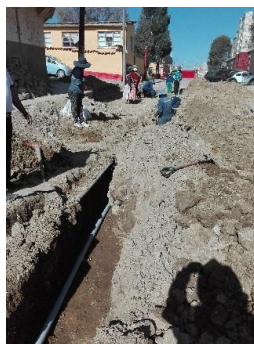
IMAGEN 3: Relleno de zanja
