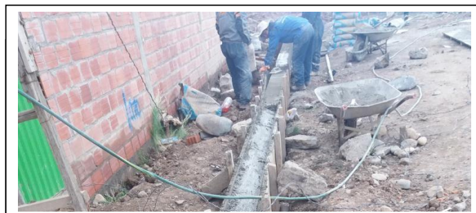
IMAGEN 2: VACIADO DEL CORDON DE ACERA
