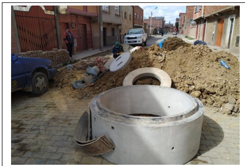
IMAGEN 2: CONSTRUCCIÓN DE CÁMARA Y COMPACTADO
