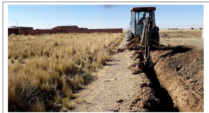
IMAGEN 2: Excavación de zanja agua potable
