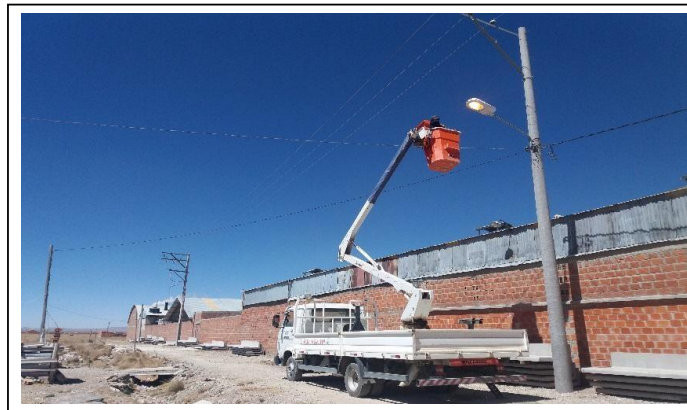
IMAGEN 2: Cambio de lámpara en mal estado
