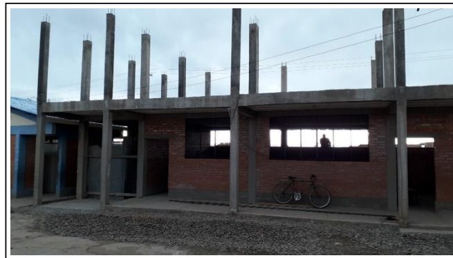
IMAGEN 1: Vista general de intervención
