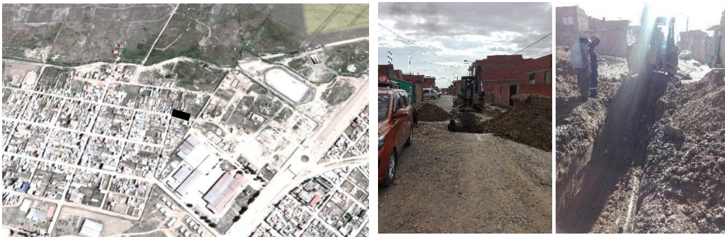
IMAGEN 2: perfilado y Tendido de tubería,
