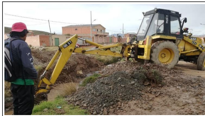
IMAGEN 2: Armado de gaviones
