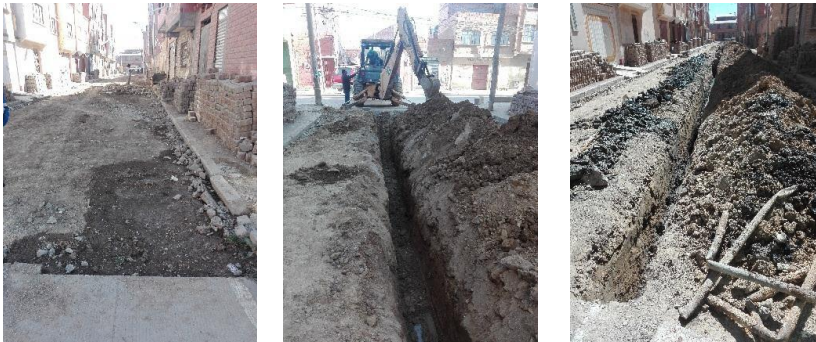
IMAGEN 2: Tendido de tubería,
