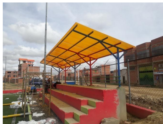
IMAGEN 3: ESTRUCTURA METALICA Y CUBIERTA DE POLICARBONATO
