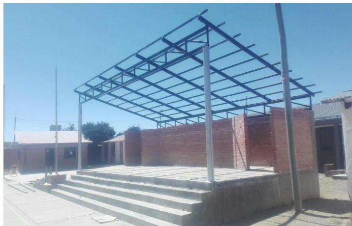
IMAGEN 1: CONSTRUCCIÓN PROSCENIO U.E. VILLA REMEDIOS
