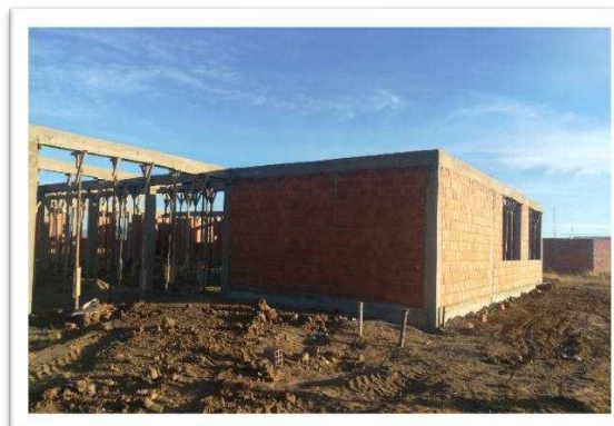
IMAGEN 2: MURO DE LADRILLO DE 6H E=0.12 M
