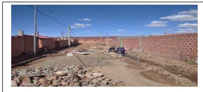
IMAGEN 1: VACIADO DE CORDONES DE ACERA
