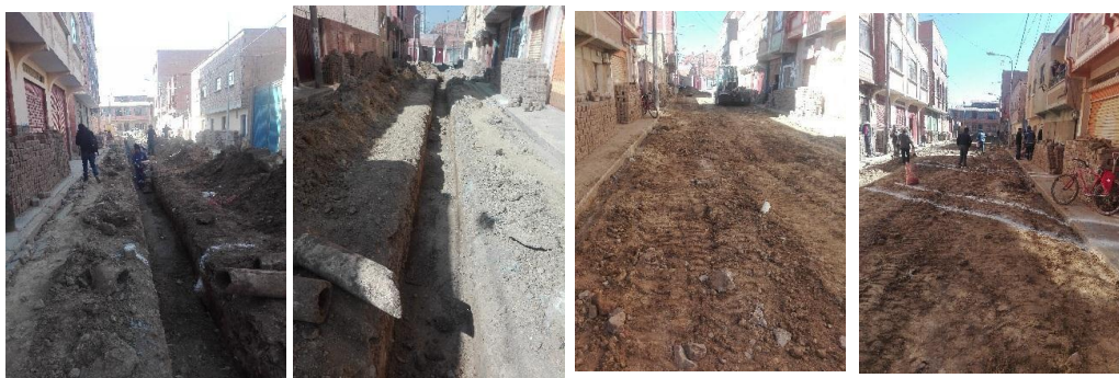
IMAGEN 3: Relleno y compactado, Limpieza
