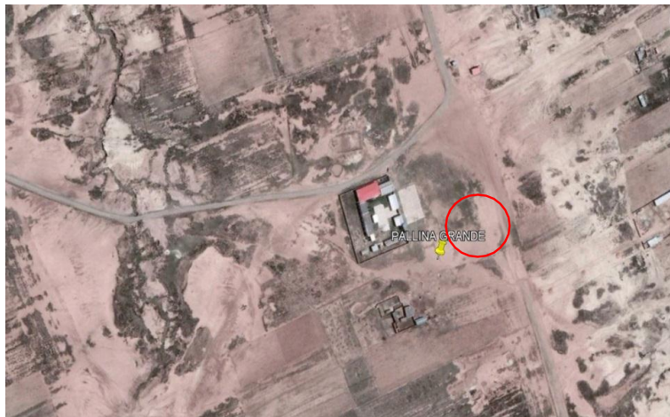
IMAGEN 1: CONSTRUCCIÓN BAÑO ANTISARNICO
