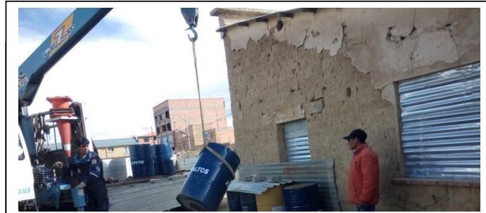
IMAGEN 3: Ferreteria (Obra Concluida)
