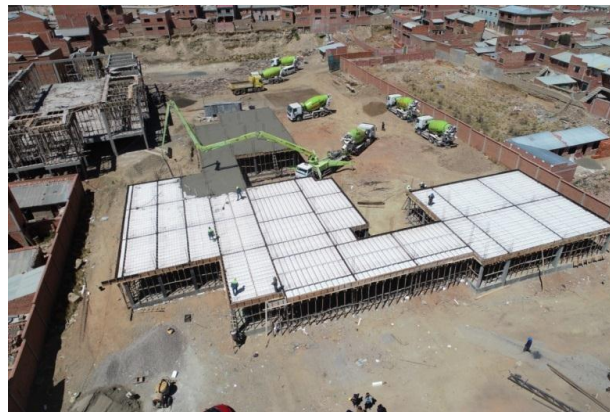
IMAGEN 2: (VACIADO LOSA PRIMER NIVEL)
