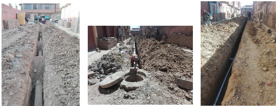
IMAGEN 3: Relleno y compactado, Limpieza
