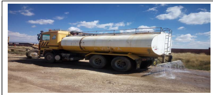
IMAGEN 2: REGADO (Obra al 50%)
