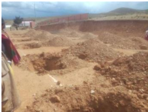
IMAGEN 1: CONSTRUCCIÓN CASA CULTURAL
