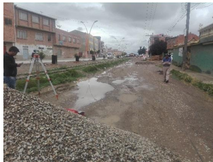
IMAGEN 2: Tendido de tubería, relleno y compactado
