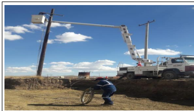
IMAGEN 2: Desmontaje y montaje de la estructura en líneas aéreas de Media Tensión (para acceso a doble vía)
