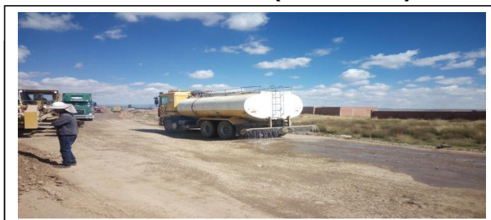
IMAGEN 2: REGADO (Obra al 50%)
