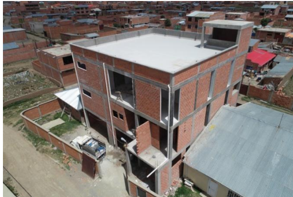
IMAGEN 1: AL INICIO DE LA OBRA
