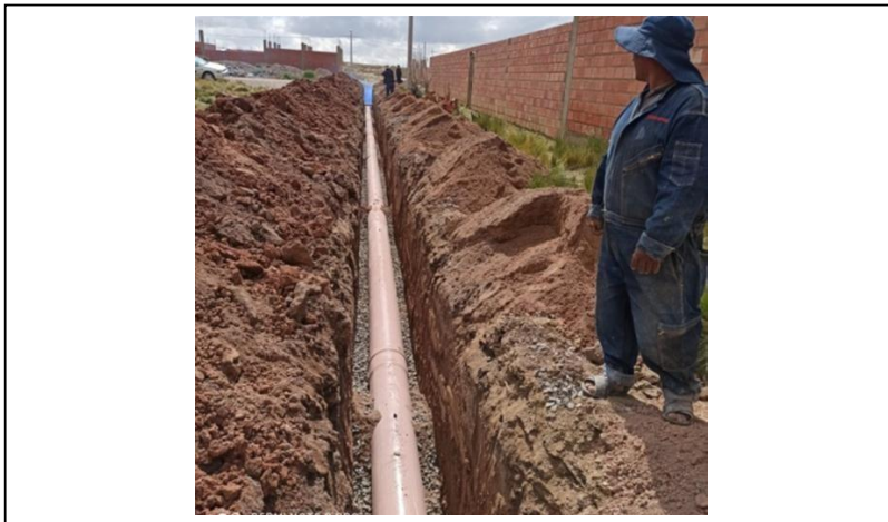
IMAGEN 1: INSPECCION Y TENDIDO DE TUBERIA
