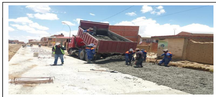
IMAGEN 2: APLICACIÓN DEL HORMIGON
