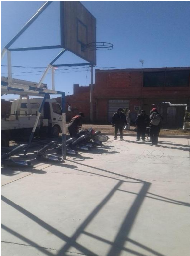
ARMADO DE LUMINARIAS Y COLOCADOS
