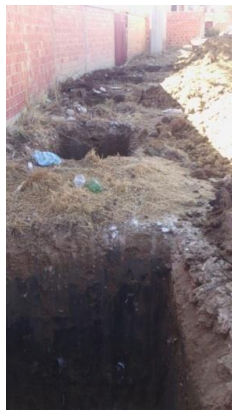
Fuente: Archivo Dirección de Infraestructura
