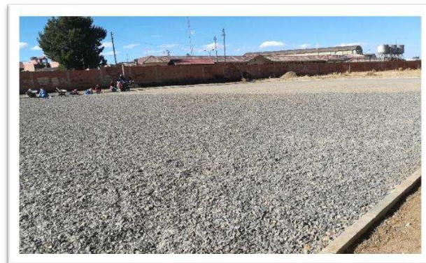
IMAGEN 1: TENDIDO DE GRAVA
