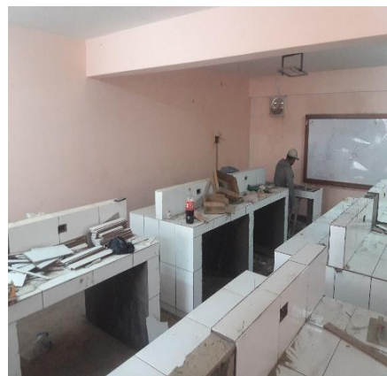
IMAGEN 3: ACABADO DE LOS MESONES CON CERÁMICA
