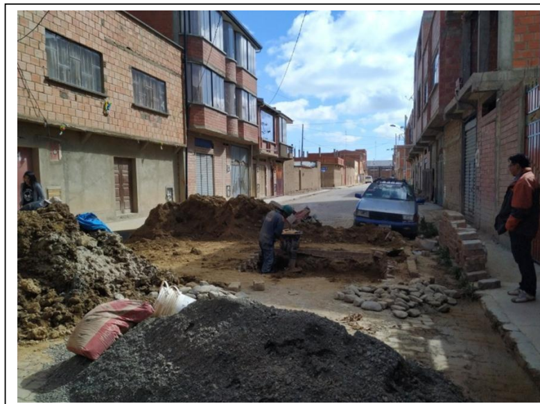
IMAGEN 2: CONSTRUCCIÓN DE CÁMARA Y COMPACTADO
