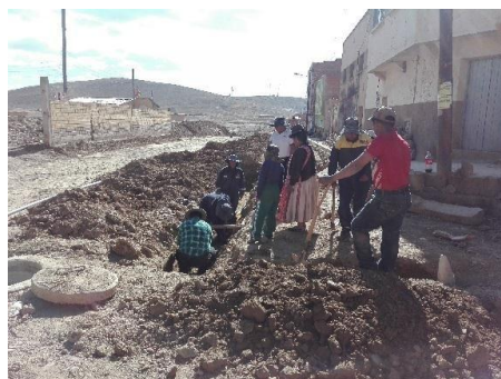
IMAGEN 3: Relleno de zanja
