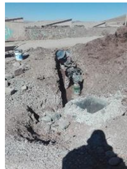
IMAGEN 2: Tendido de tubería, Relleno y compactado
