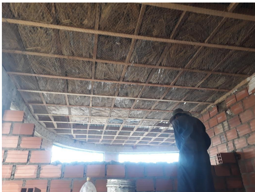
IMAGEN 2: ENMALLADO DEL CIELO FALSO
