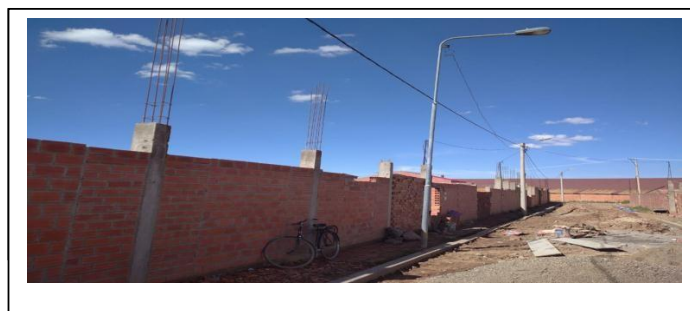
IMAGEN 3: CORDON DE ACERA CONCLUIDO
