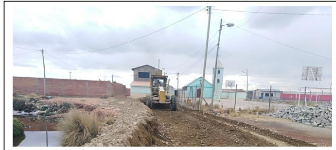
IMAGEN 1: CONFORMACION DE PLATAFORMA
