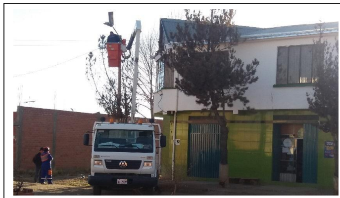
IMAGEN 2: Cambio de lámpara en mal estado
