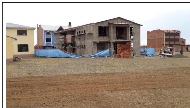
IMAGEN 2: Revoque con mortero de cemento
