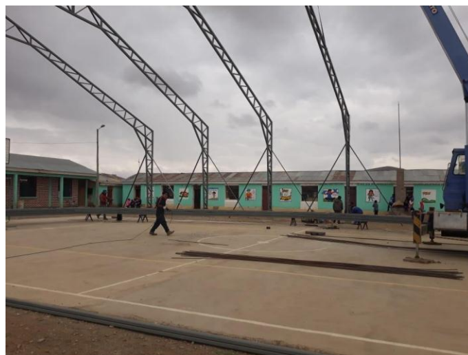
IMAGEN 1: CONSTRUCCIÓN TINGLADO POLIFUNCIONAL U.E. JALSURI
