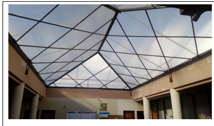
IMAGEN 1: Cambio de cubierta
