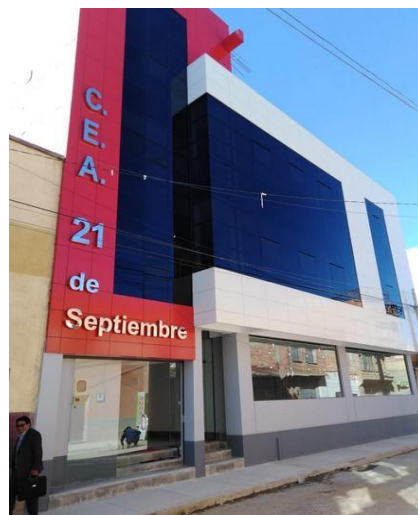
IMAGEN 2: Entrega del CEA 21 de Septiembre (Obra al 100%)
