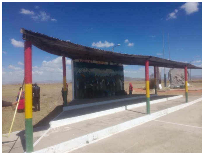
IMAGEN 1: MEJORAMIENTO CUBIERTA CAMPOS DE INGAVI
