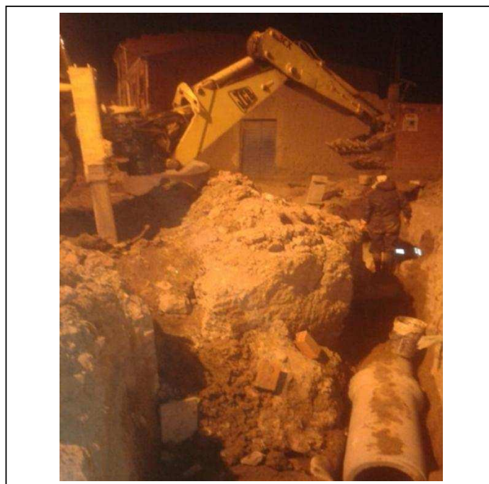
IMAGEN 2: CONSTRUCCIÓN DE CÁMARA Y COMPACTADO
