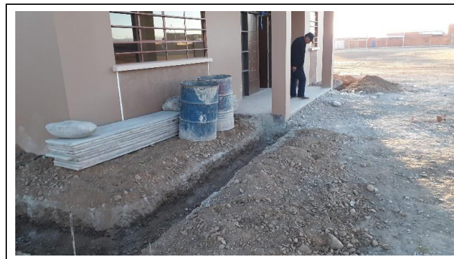
IMAGEN 2: Excavación de cordón
