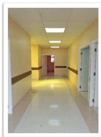
IMAGEN 3: CIELO FALSO PLAFÓN CON PERFILES DE ALUMINIO
