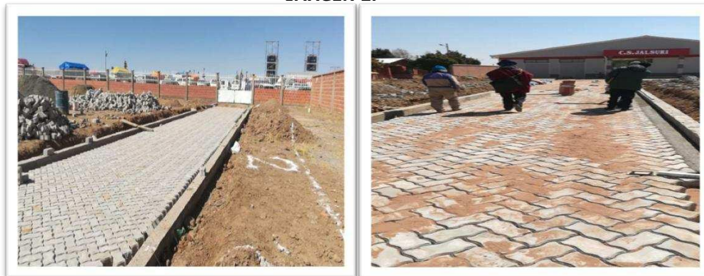
Fuente: Archivo Dirección de Infraestructura
