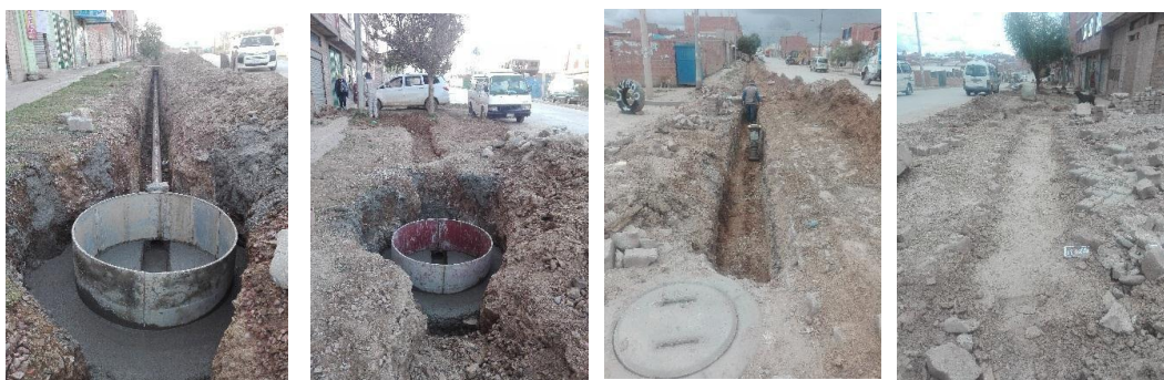
IMAGEN 3: CAMARAS DE INSPECCION RELLENO Y COMPACTADO
