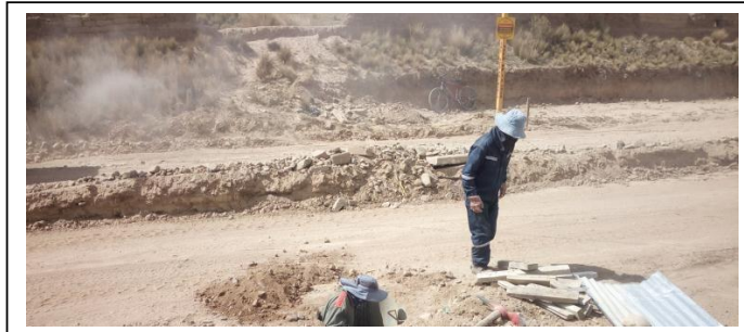
IMAGEN 1: Corte terreno, tapado de C.I. (Inicio de Obra)
