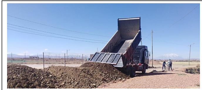
IMAGEN 1: ACAMELLONADO DE MATERIAL ARIDO
