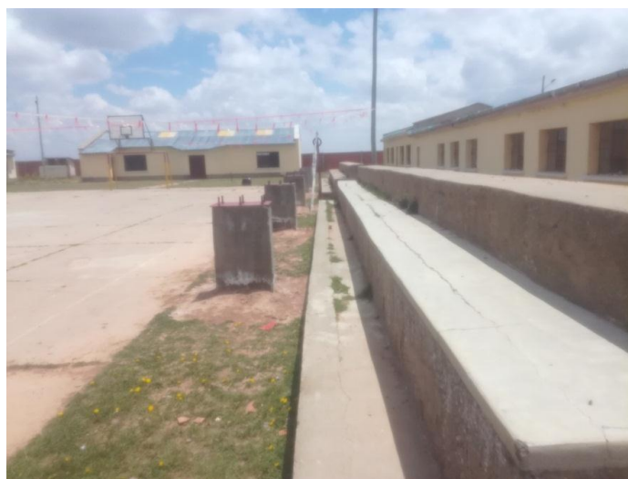
IMAGEN 2: CONSTRUCCIÓN TINGLADO POLIFUNCIONAL U.E. MAX TOLEDO
