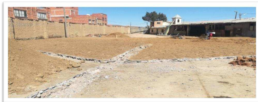
IMAGEN 2: TRAZADO Y CONFORMACIÓN DE PLATAFORMA
