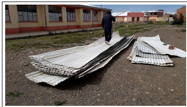
IMAGEN 1: Retiro de calamina en mal estado
