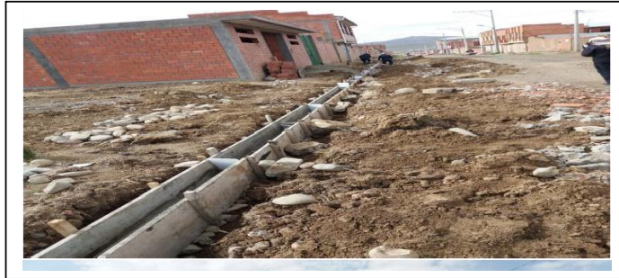
IMAGEN 1: ENCOFRADO DE CORDONES DE ACERA
