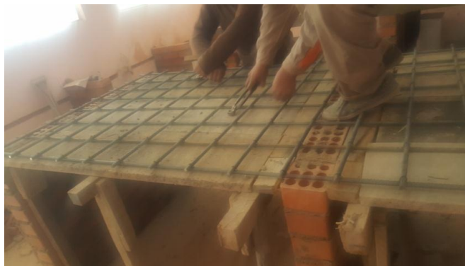
IMAGEN 1: ARMADO DEL MESON
