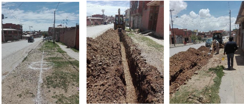
IMAGEN 1: TRAZADO Y REPLANTEO, EXCAVACION
