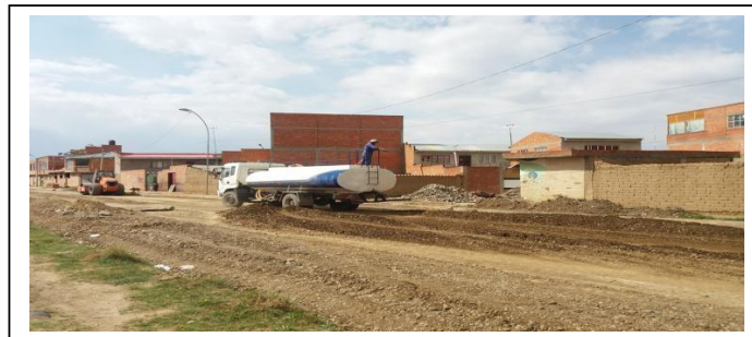
IMAGEN 1: CONFORMACIÓN DE PLATAFORMA
