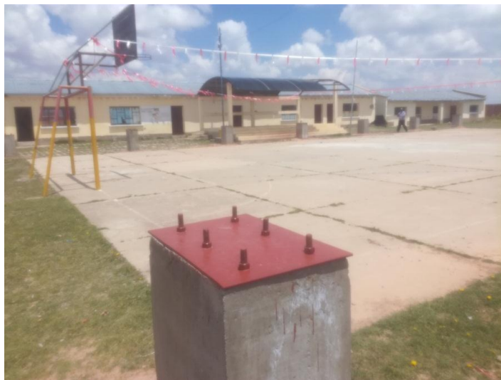
IMAGEN 1: CONSTRUCCIÓN TINGLADO POLIFUNCIONAL U.E. MAX TOLEDO
