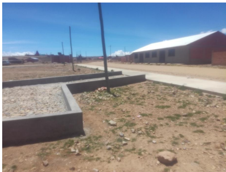
IMAGEN 1: CONSTRUCCIÓN PLAZA PRINCIPAL
