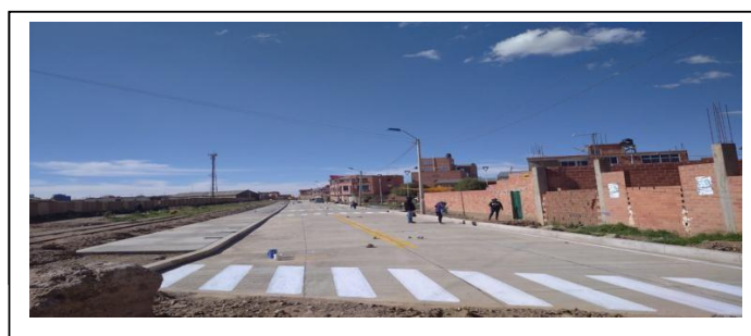
IMAGEN 3: EN EJECUCION APLICACION DEL HORMIGON
