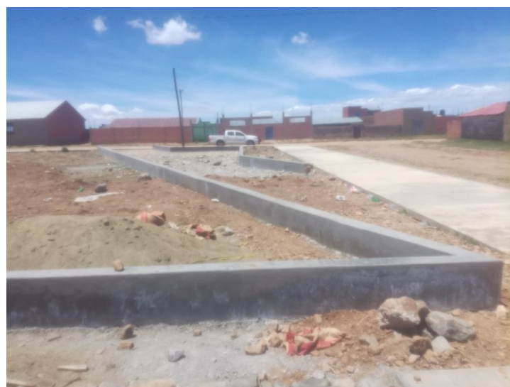
IMAGEN 2: CONSTRUCCIÓN PLAZA PRINCIPAL
