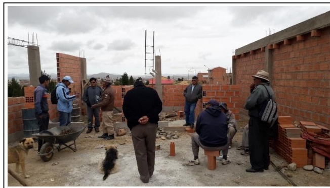
IMAGEN 1: Inspección técnica y autoridades, muro de ladrillo y viga de encadenado
