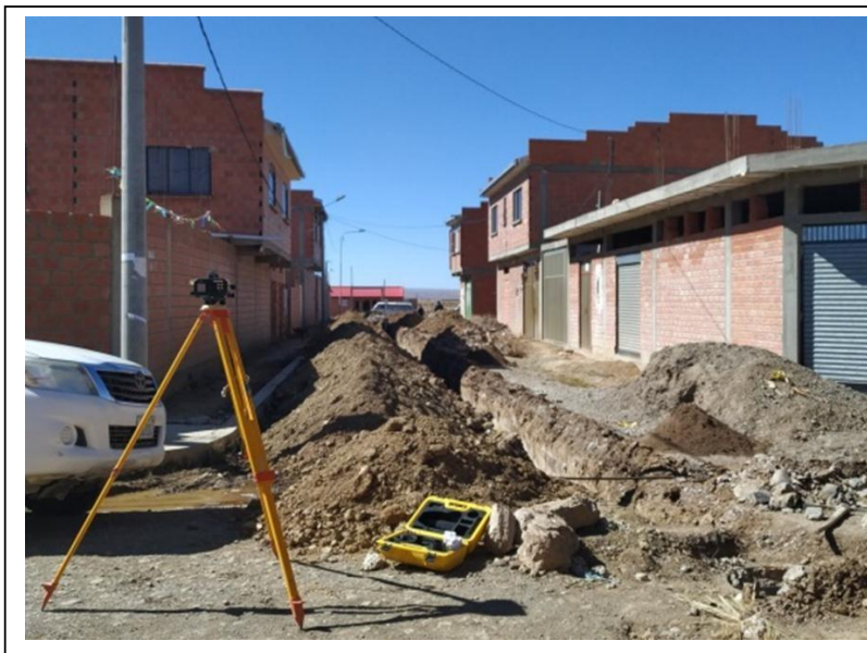
IMAGEN 2: NIVELACION Y TENDIDO DE TUBERIA
