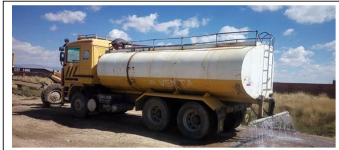
IMAGEN 1: REGADO DEL TRAMO B CON CISTERNA
