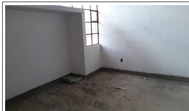
IMAGEN 3: Revoque de muro con yeso
