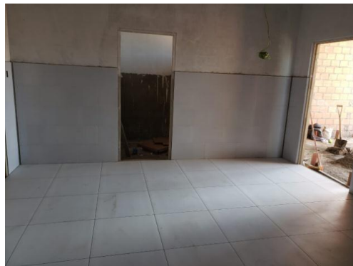
IMAGEN 3: REVESTIMIENTO Y PISO DE CERAMICA
