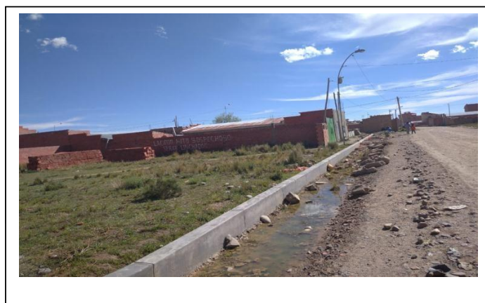
IMAGEN 2: CORDON DE ACERA CONCLUIDO
