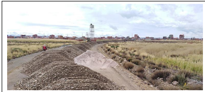
IMAGEN 2: APLICACIÓN DE HORMIGON
