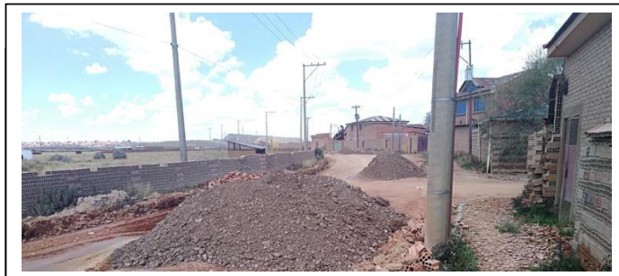
IMAGEN 2: ACAMELLONADO DE RIPIO SECTOR LADRILLERAS
