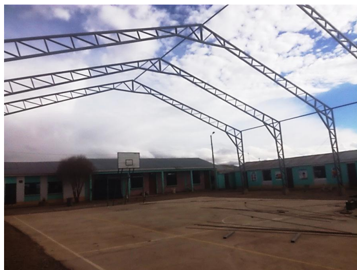
IMAGEN 2: CONSTRUCCIÓN TINGLADO POLIFUNCIONAL U.E. JALSURI
