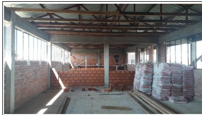
IMAGEN 1: Tabiquería de ladrillo
