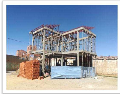
IMAGEN 1: CUB. DE CALAMINA Nº28 + ESTRUCTURA MET.
