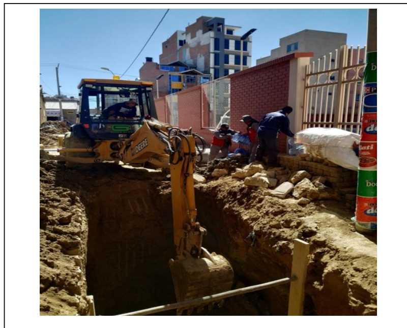
IMAGEN 2: EXCAVACION DE RED Y LIMPIEZA
