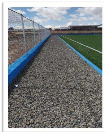
IMAGEN 2: TENDIDO DE GRAVA E=5 CM
