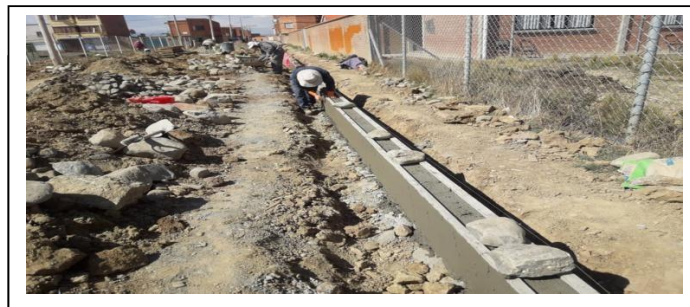
IMAGEN 2: VACIADO DE CORDONES
