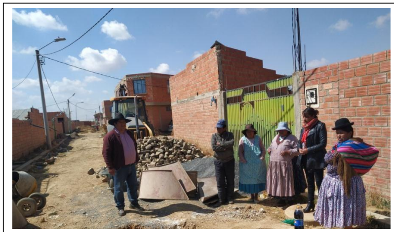
IMAGEN 1: INSPECCION DE OBRA
