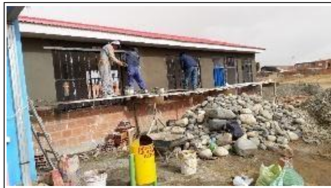
IMAGEN 3: Vaciado de Carpeta de HºSº con empedrado Urb. Wara
