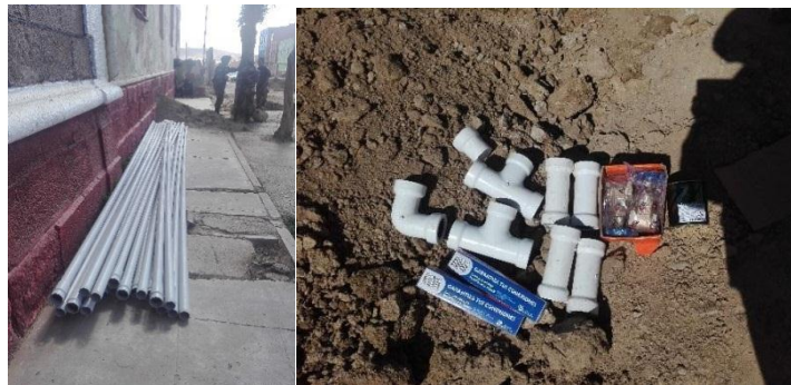
IMAGEN 2: Tendido de tubería
