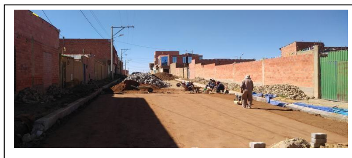
IMAGEN 2: EJECUCION DE ENLOSETADO
