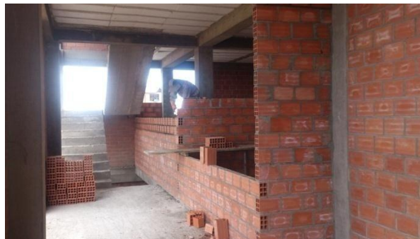
IMAGEN 2: MURO DE LADRILLO DE 6 HUECOS
