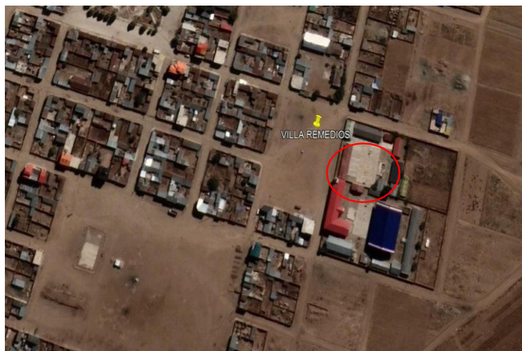
IMAGEN 1: CONSTRUCCIÓN TINGLADO U.E. VILLA REMEDIOS
