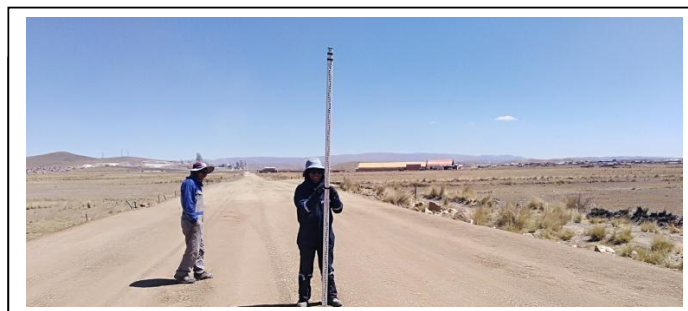
IMAGEN 2: PLATAFORMA CONFORMADA Y NIVELACION
