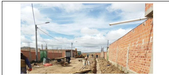
IMAGEN 1: VACIADO DE CORDONES DE ACERA
