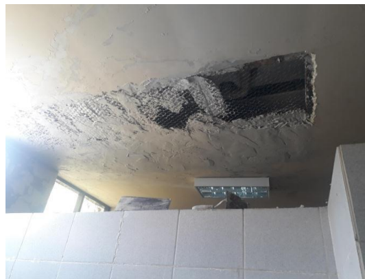
Fuente: Archivo Dirección de Infraestructura
