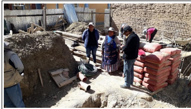
IMAGEN 1: Vista general de intervención y J.E.
