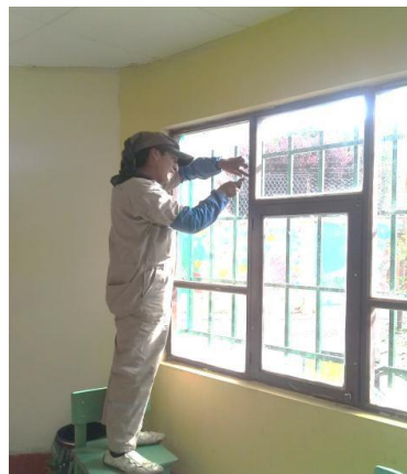
Fuente: Archivo Dirección de Infraestructura
