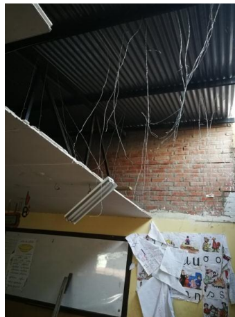
Fuente: Archivo Dirección de Infraestructura
