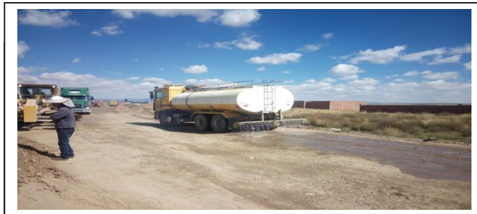
IMAGEN 3: SALIDA REGADO (Obra Concluida)
