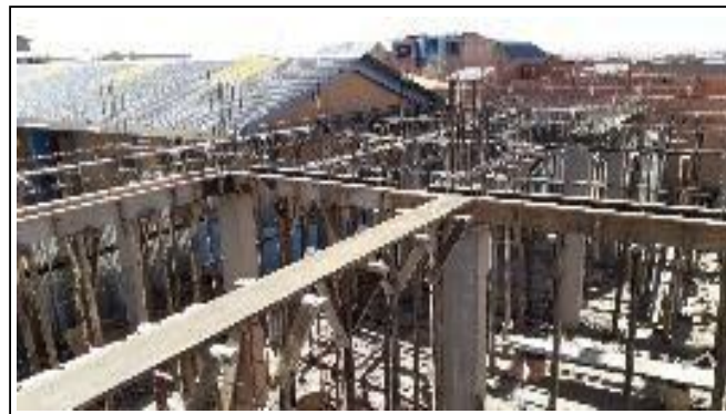
IMAGEN 2: Encofrado para posterior vaciado de columnas
