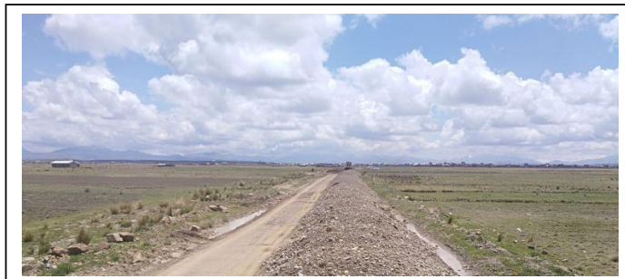
IMAGEN 1: ACAMELLONADO DE MATERIAL ARIDO
