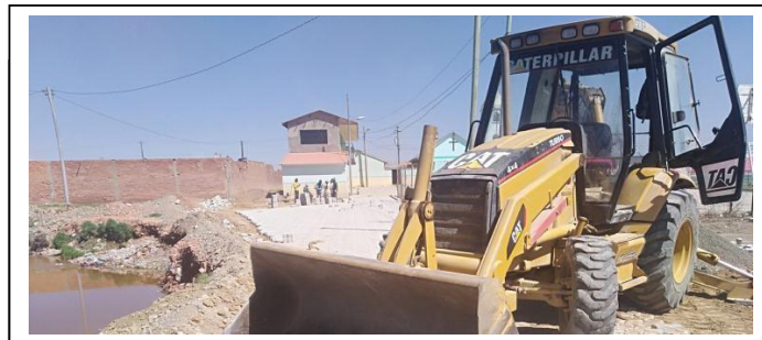
IMAGEN 2: RETROEXCAVADORA PARA TENDIDO DE TUBERIAS
