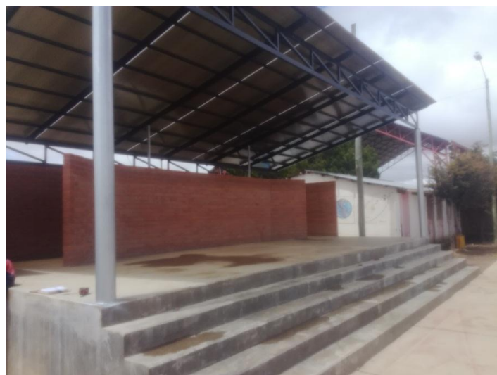
IMAGEN 2: CONSTRUCCIÓN PROSCENIO U.E. VILLA REMEDIOS
