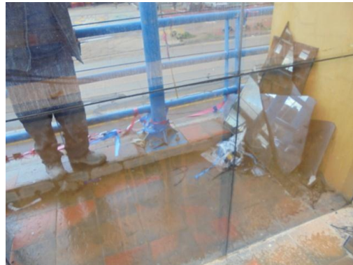
Fuente: Archivo Dirección de Infraestructura
