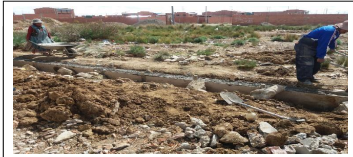
IMAGEN 2: VACIADO DEL CORDON DE ACERA
