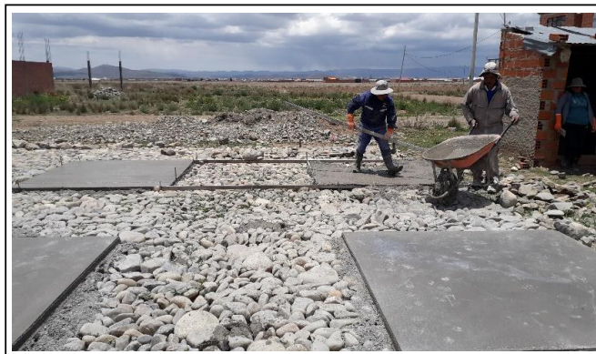
IMAGEN 3: Vaciado de Carpeta de HºSº con empedrado Urb. Wara
