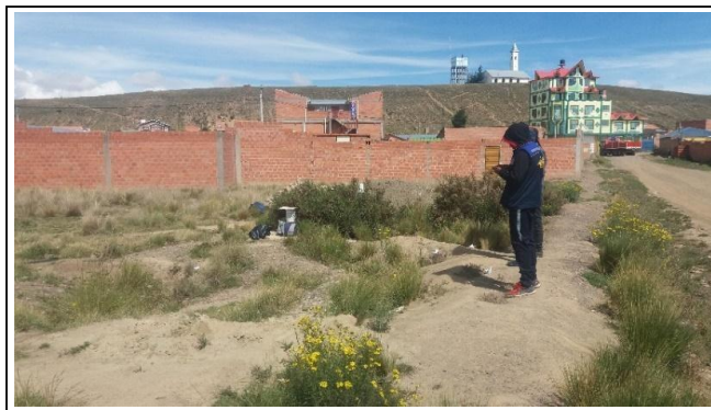
IMAGEN 2: Muros de ladrillo, puertas y revoque interior con mortero de cemento
