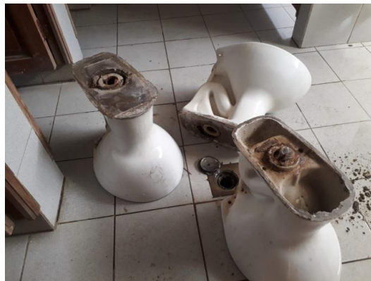
Fuente: Archivo Dirección de Infraestructura
