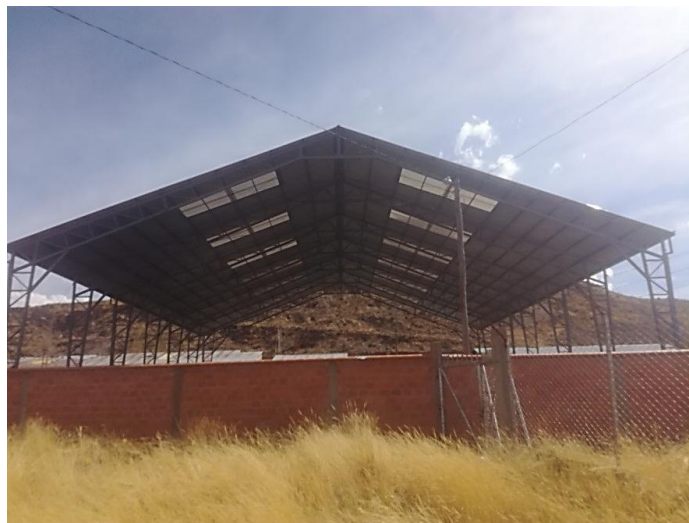
IMAGEN 2: CONSTRUCCIÓN TINGLADO POLIFUNCIONAL U.E. PAN DE AZUCAR
