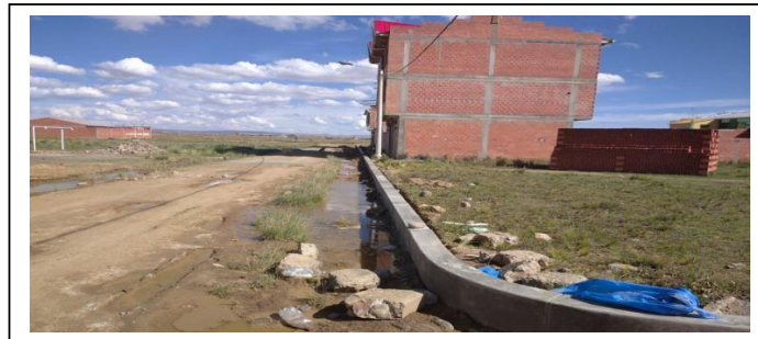
IMAGEN 1: VACIADO DE CORDONES DE ACERA
