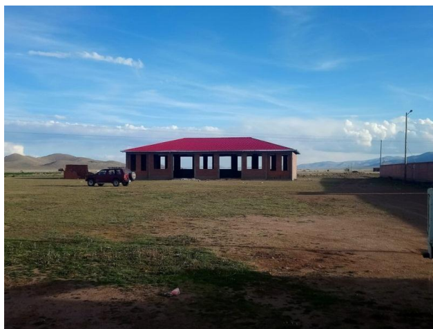
IMAGEN 2: CONSTRUCCIÓN CASA CULTURAL MARCA JACHA HILATA
