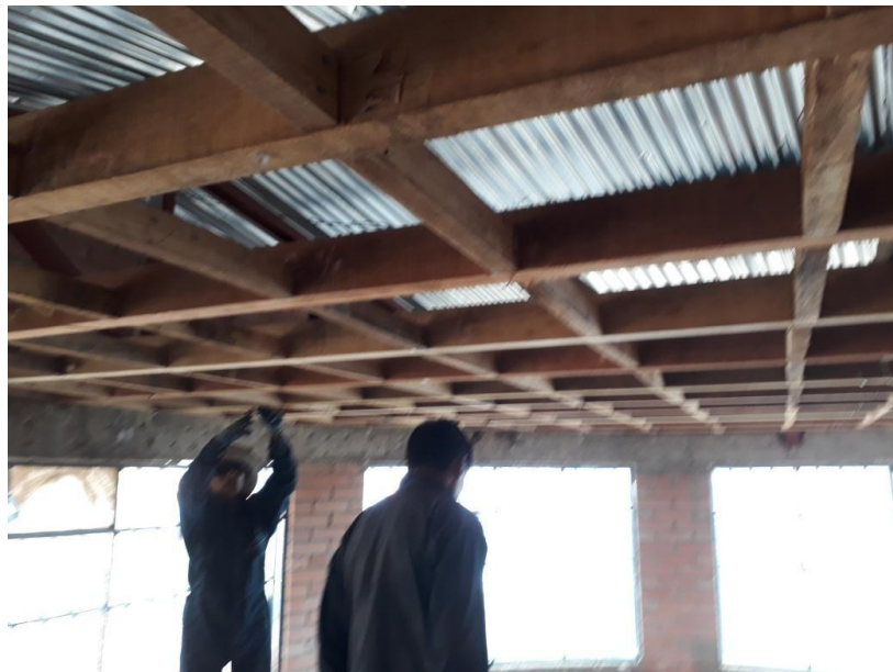
IMAGEN 1: ARMADO DE LA ESTRUCTURA DE MADERA
