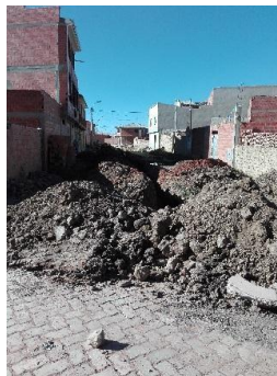
IMAGEN 2: Tendido de tubería y relleno
