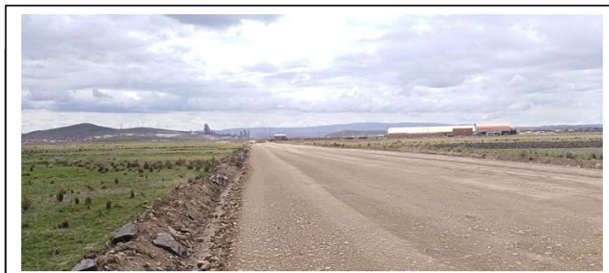
IMAGEN 2: PLATAFORMA CONFORMADA
