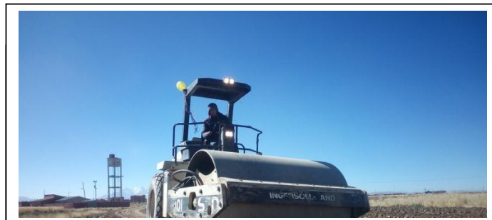
IMAGEN 3: Vibrocompactadora (Obra Concluida)
