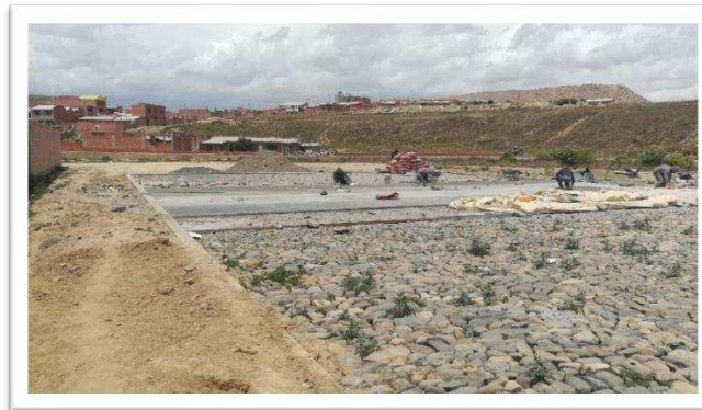
IMAGEN 1: PISO DE CEMENTO RESISTENCIA 210 S/EMPEDRADO
