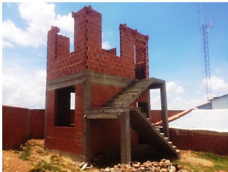
IMAGEN 2: CONSTRUCCIÓN CASA DE VIGILANCIA U.E. VILLA ARRIENDO
