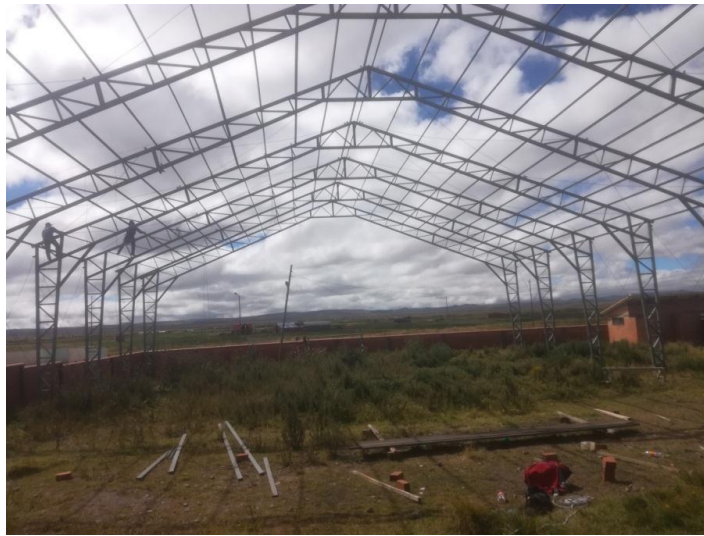
IMAGEN 1: CONSTRUCCIÓN TINGLADO POLIFUNCIONAL U.E. PAN DE AZÚCAR
