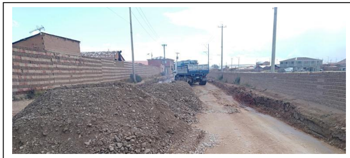
IMAGEN 1: ACAMELLONADO DE RIPIO PARA MEJORAMIENTO DE VIA
