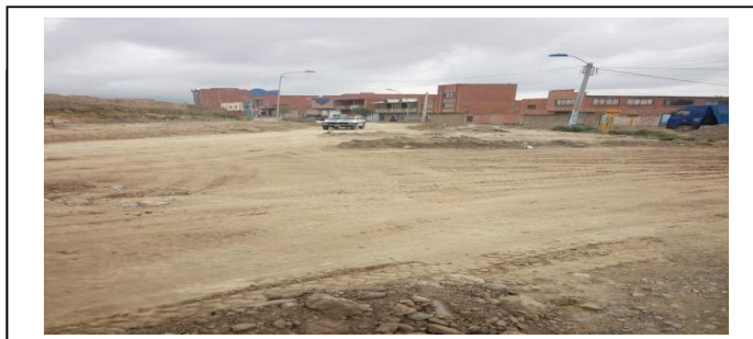
IMAGEN 3: Plataforma (Obra Concluida)
