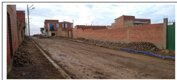
IMAGEN 1: PLATAFORMA CONFORMADA
