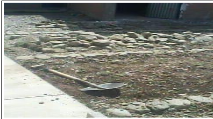
IMAGEN 1: NIVELACION TERRENO (MANUAL) + TIERRA SELECCIONADA
