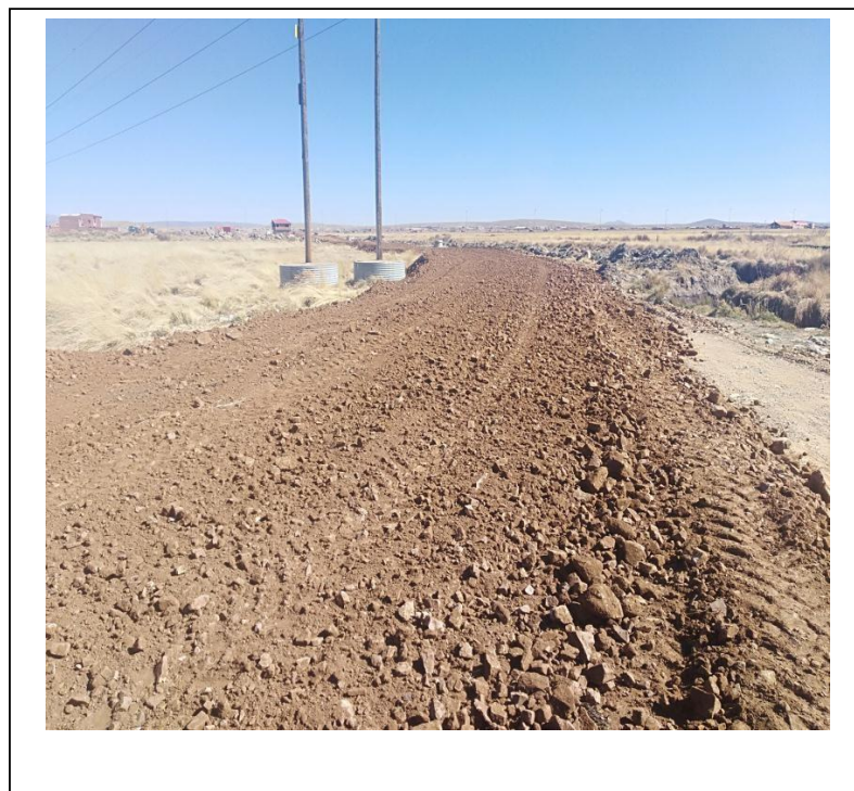
IMAGEN 1: MAERIAL RIPIO PARA LA HABILITACION DE VIA
