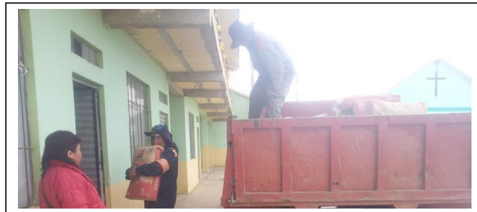
IMAGEN 1: DESCARGA DE CEMENTO
