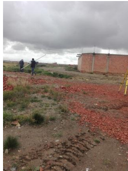
IMAGEN 2: Tendido de tubería, relleno y compactado
