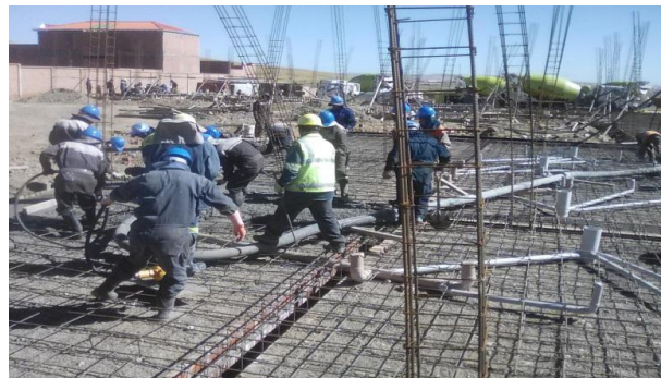
IMAGEN 1: (VACIADO DE LOSA RADIER)
