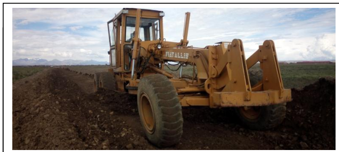
IMAGEN 2: PLATAFORMA EN CONFORMACION
