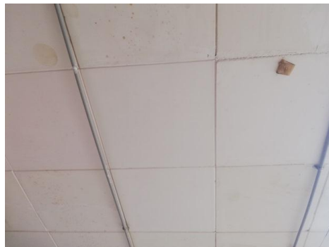
IMAGEN 1: PROV. Y COLOC. DE PLAFONES
