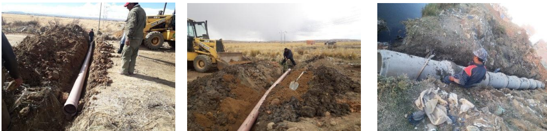
IMAGEN 2: perfilado y Tendido de tubería,
