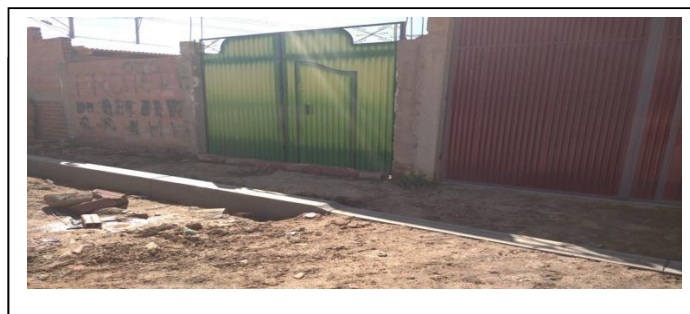
IMAGEN 2: VACIADO DEL CORDON DE ACERA
