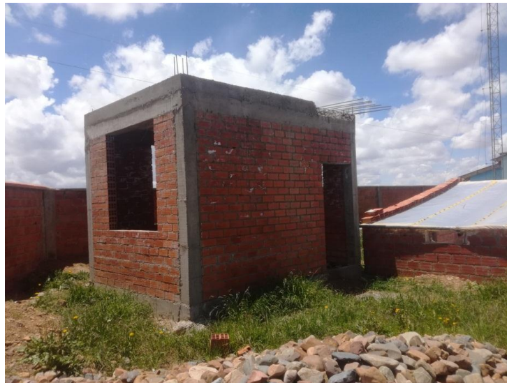
IMAGEN 1: CONSTRUCCIÓN CASA DE VIGILANCIA U.E. VILLA ARRIENDO
