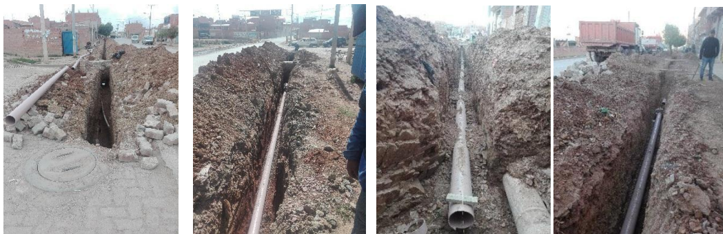
IMAGEN 3: CAMARAS DE INSPECCION RELLENO Y COMPACTADO
