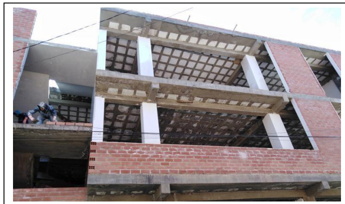
IMAGEN 1: Revoque de yeso en interiores (Inicio de Obra)
