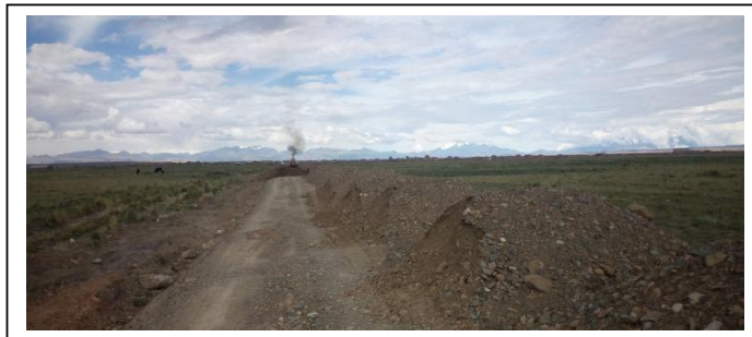
IMAGEN 1: ACAMELLONADO DE MATERIAL ARIDO
