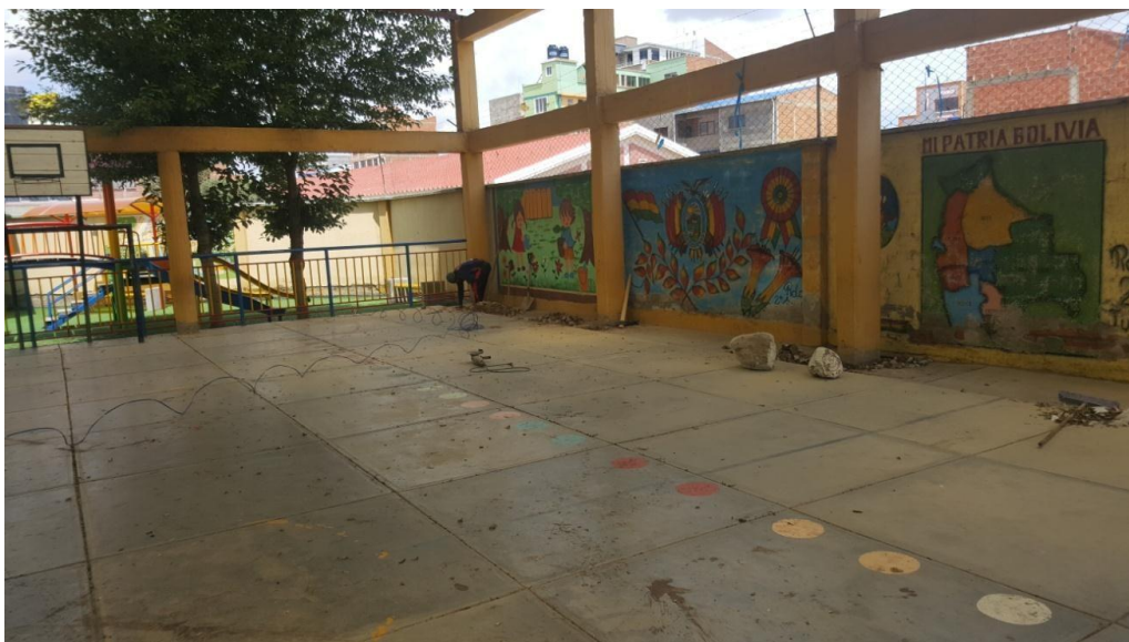
IMAGEN 2: EXCAVACION (0-2 M.) SUELO BLANDO
