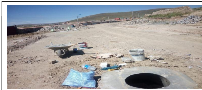
IMAGEN 2: REALIZACION DE C.I. (Obra al 50%)
