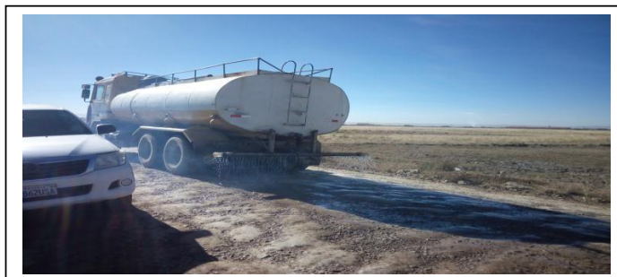
IMAGEN 1: VISTA GENERAL REGADO (Inicio de Obra)
