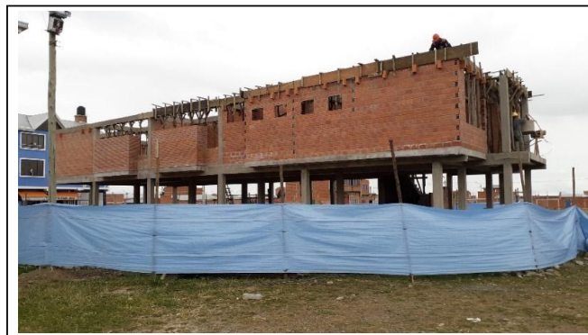
IMAGEN 1: Muro de ladrillo, vigas de encadenado
