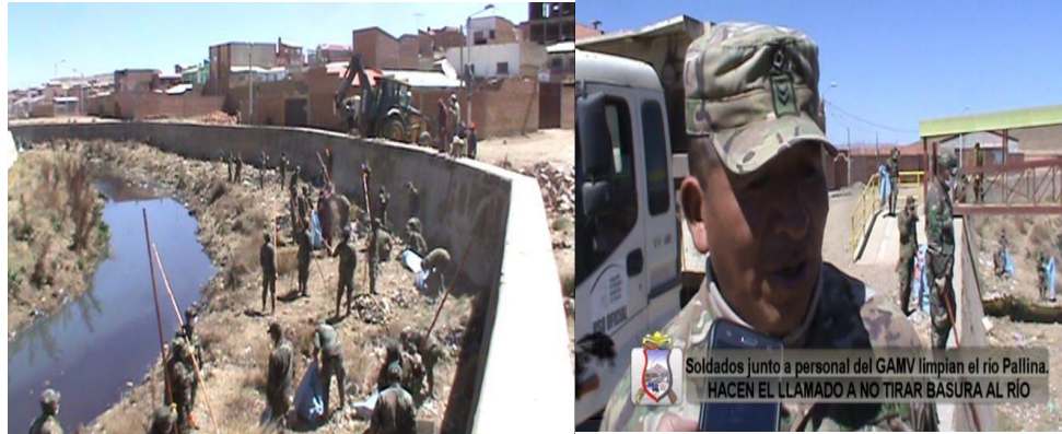
IMAGEN N° 1 PUNTO PUENTE DORIA MEDINA
