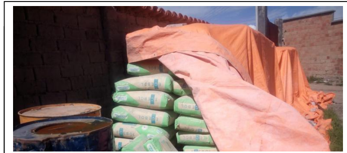
IMAGEN 2: Cemento (Obra al 50%)
