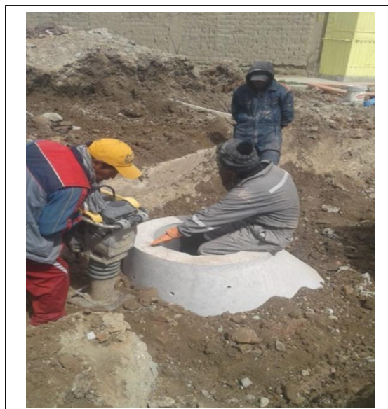
IMAGEN 2: CONSTRUCCIÓN DE CÁMARA Y COMPACTADO
