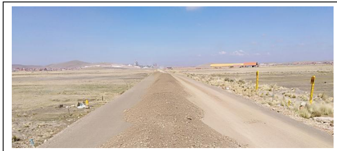
IMAGEN 2: PLATAFORMA CONFORMADA Y NIVELACION
