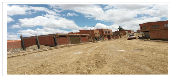
IMAGEN 2: CONFORMACION DE PLATAFORMA
