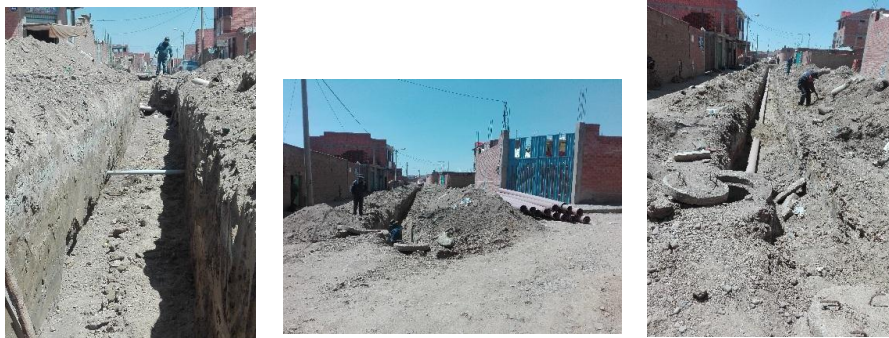
IMAGEN 3: Relleno con material común
