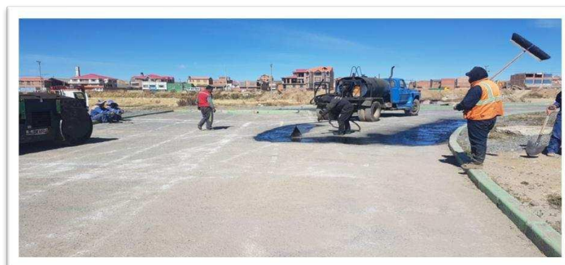
IMAGEN 2: CONFORMACIÓN DE CAPA BASE
