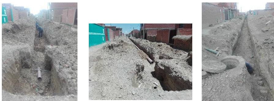
IMAGEN 3: Relleno con material común
