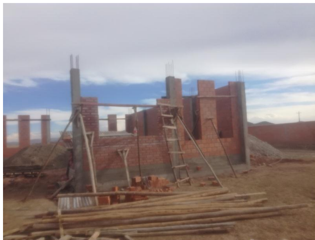
IMAGEN 1: CONSTRUCCIÓN CASA CULTURAL MARCA JACHA HILATA
