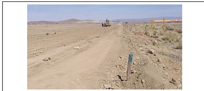
IMAGEN 1: ESTACADO PARA DELIMITACION DE VIA
