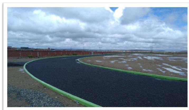
IMAGEN 3: IMPRIMACIÓN DE ASFALTO EN FRIO
