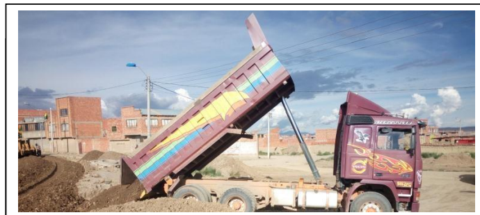
IMAGEN 2: Volquetas (Obra al 50%)
