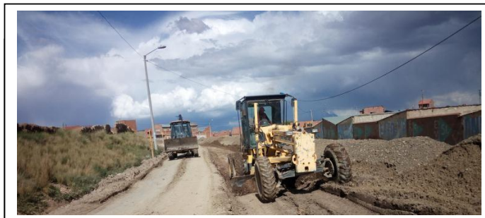
IMAGEN 2: Conformación de plataforma (Obra al 50%)
