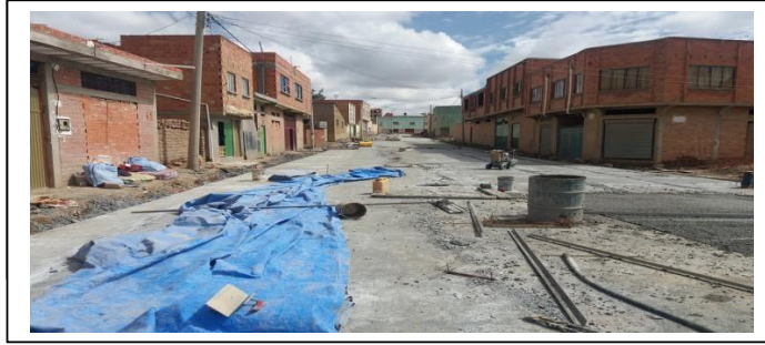
IMAGEN 3: EN EJECUCION APLICACION DEL HORMIGON
