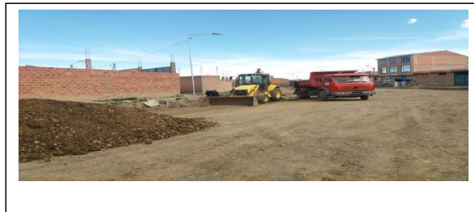
IMAGEN 1: CORTE Y RETIRO DE MATERIAL
