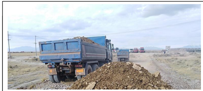
IMAGEN 2: ACAMELLONADO DE RIPIO PARA MEJORAMIENTO DE VIA
