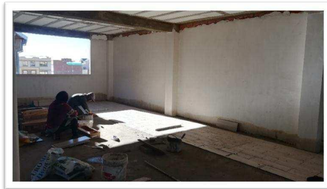
IMAGEN 1: REVOQUE DE YESO EN INTERIORES
