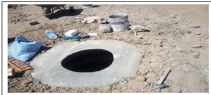
IMAGEN 1: CAMARA DE INSPECCION (Inicio de Obra)
