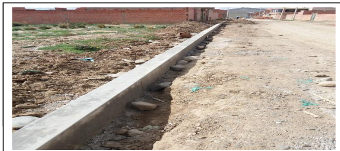
IMAGEN 3: CORDON DE ACERA CONCLUIDO
