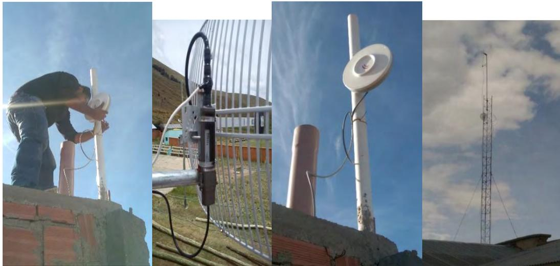
**Equipos de Radio Enlace montado con elementos de protección contra sobretensiones, sistema de Puesta a Tierra y cable UTP de exteriores.**
