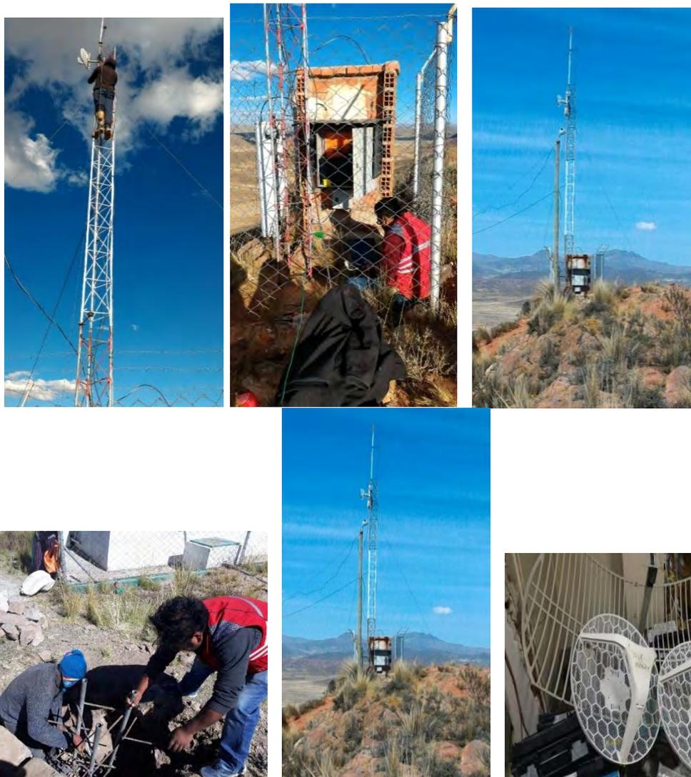
Equipos de Radio Enlace montado con elementos de protección contra sobretensiones, sistema de Puesta a Tierra y cable UTP de exteriores.
