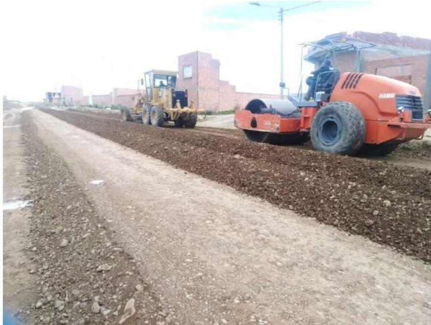
*Construcción Pavimento Rígido Avenida Villa Remedios D-1(Alquiler de Maquinaria conformación de capa base progresiva 0+230 hasta 0+442,25)*
