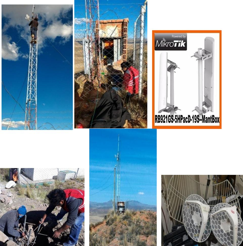
Equipos de Radio Enlace montado con elementos de protección contra sobretensiones, sistema de Puesta a Tierra y cable UTP de exteriores.
