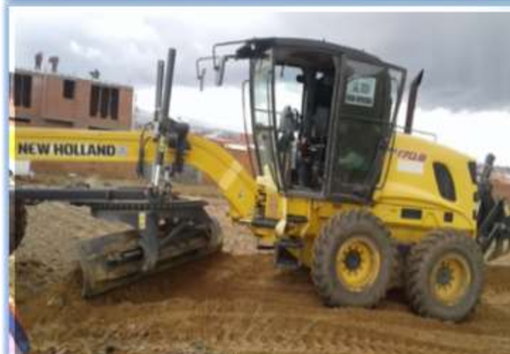
Nivelación de calles D-7
