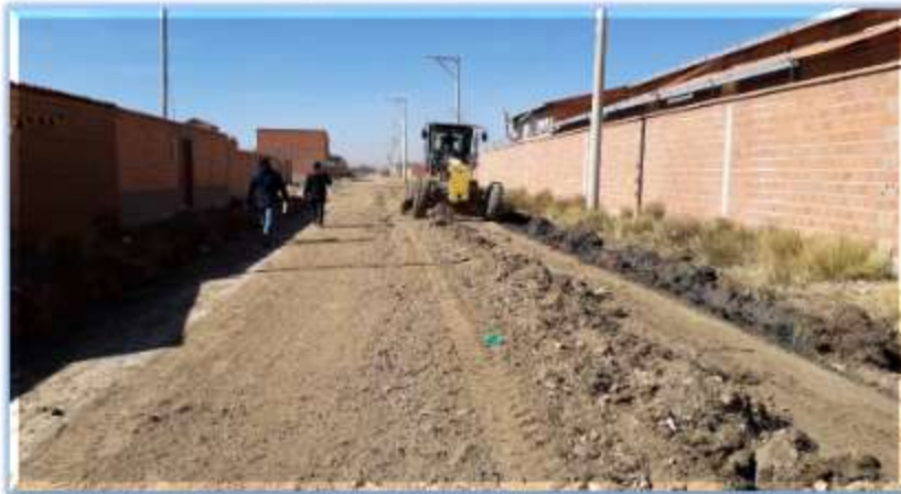
Limpeza de cunetas Urb. La Florida D -6
