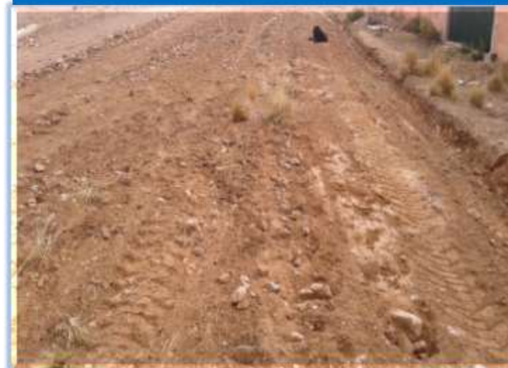
Nivelacion de avenidas D-7
