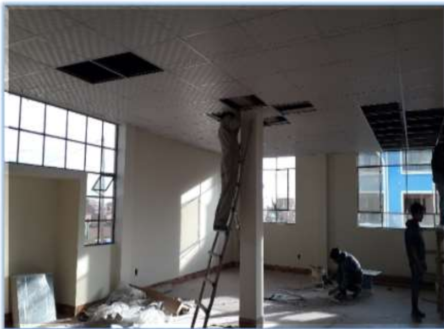
Colocado de cielo falso plafón con ferfileria de aluminio
