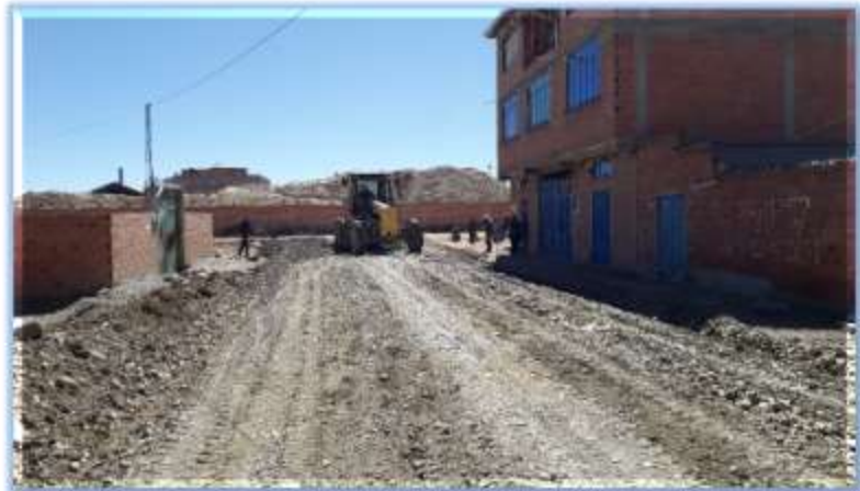
Ripiado de calles Urb. Nueva Esperanza D -6
