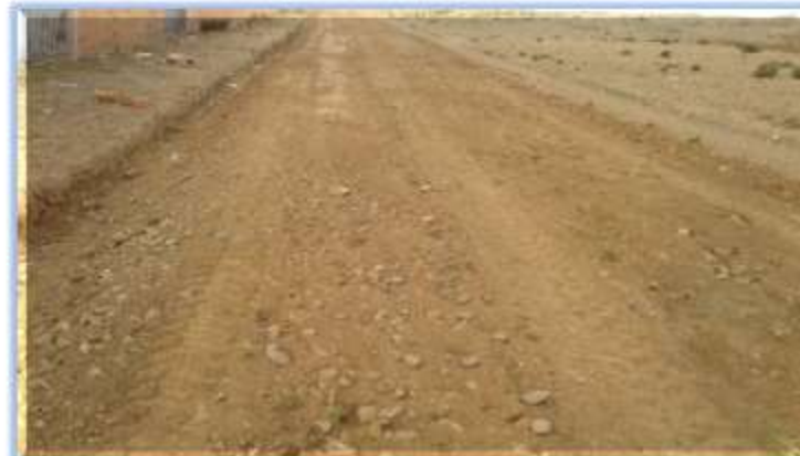
Apertura de vías D-7
