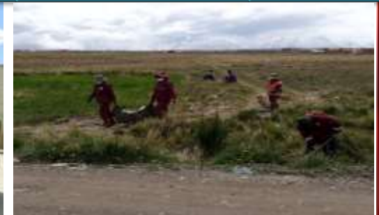
Limpieza De 30 Km lineales de Calles, Avenidas y adyacentes diarias
