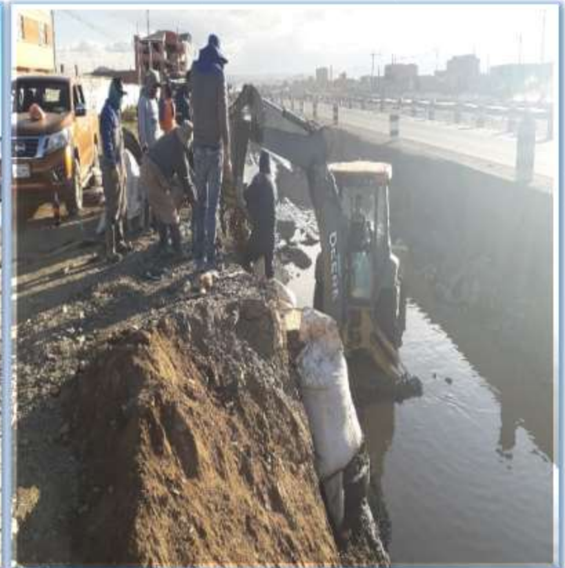
Mantenimiento del canal principal Av. Hacia El Mar
