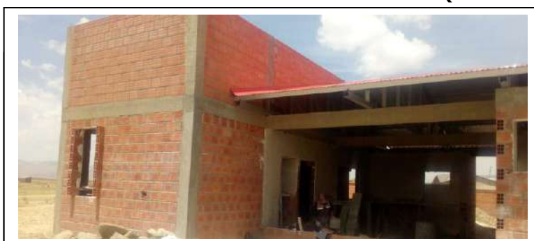
IMAGEN 3: Construcción de muros de cerramiento (Obra Concluida)
