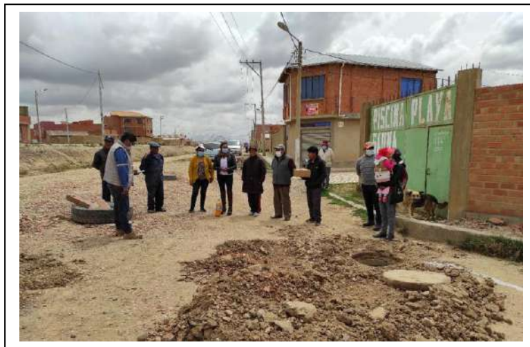
IMAGEN 1: INICIO DE OBRA
