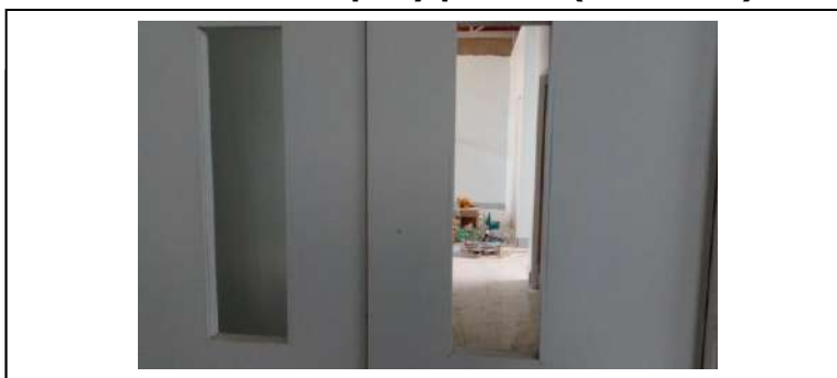
IMAGEN 2: Revoque y pintura (concluido)
