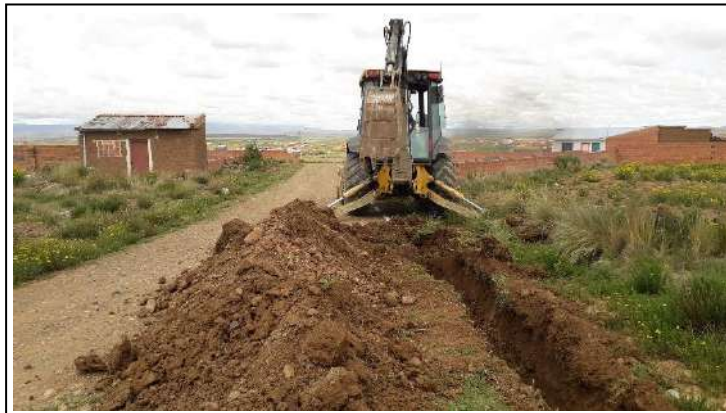
IMAGEN 1: Excavación de zanja para agua potable Urb. Machak Kantati
