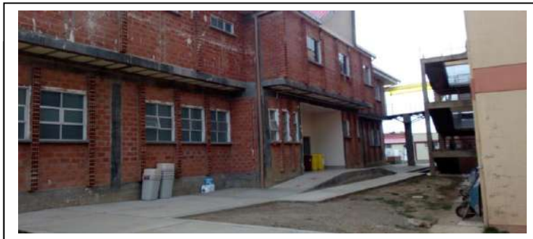
IMAGEN 2: Construcción aceras (Obra al 50%)
