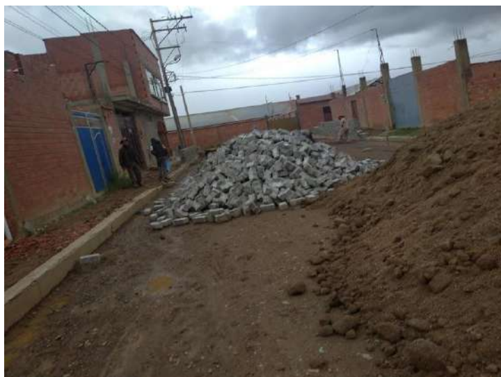
IMAGEN 2: PROVISION DE MATERIAL PARA ENLOSETAR
