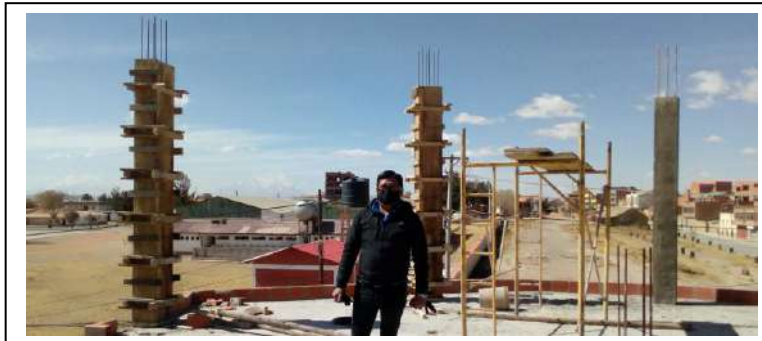
IMAGEN 1: El encofrado de columnas (Inicio de Obra)
