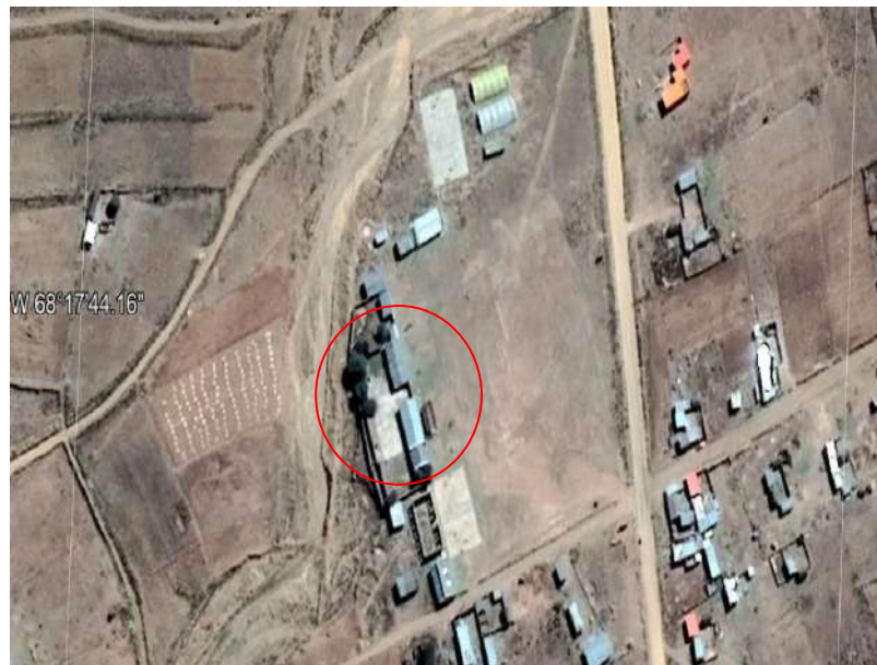
IMAGEN 1: CONSTRUCCIÓN PARQUE INFANTIL U.E. TONCOPUJIO
