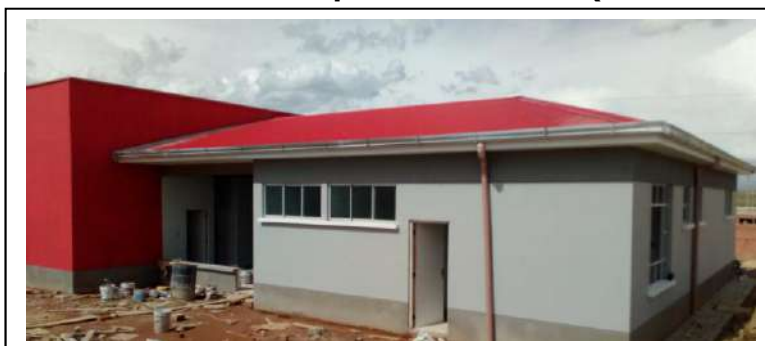
IMAGEN 3: Construcción de pintura exterior (Obra Concluida)
