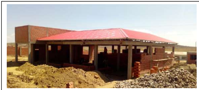
IMAGEN 1: Construcción de muro de cerramiento (Inicio de Obra)
