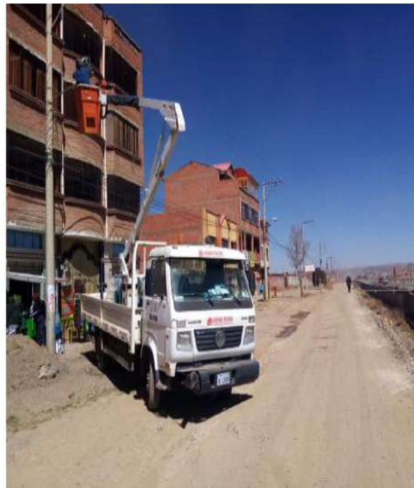
IMAGEN 1: MANTENIMIENTO DE LA RED DE ALUMBRADO PÚBLICO D-6
