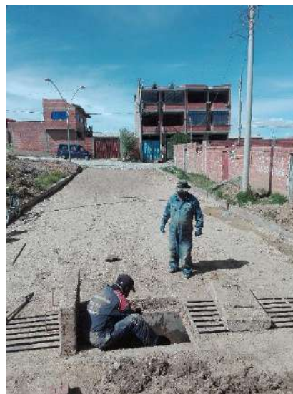
IMAGEN 2: EXTRACCION DE MATERIAL SEDIMENTADO
