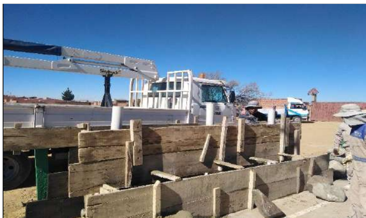
IMAGEN 3: Construcción de mástil en diferentes Urb. del Distrito 6
