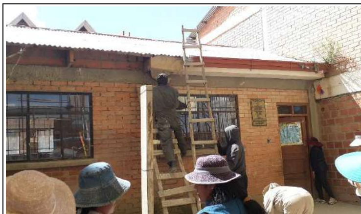
IMAGEN 3: Mantenimiento en U.E. La Florida
