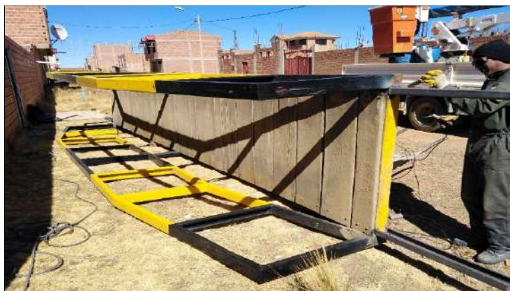
IMAGEN 2: Trabajo de Soldadura en Puente Peatonal Metálico Urb. Santa Rita
