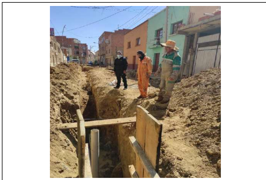
IMAGEN 1: EXCAVACIÓN Y ENTIBADO
