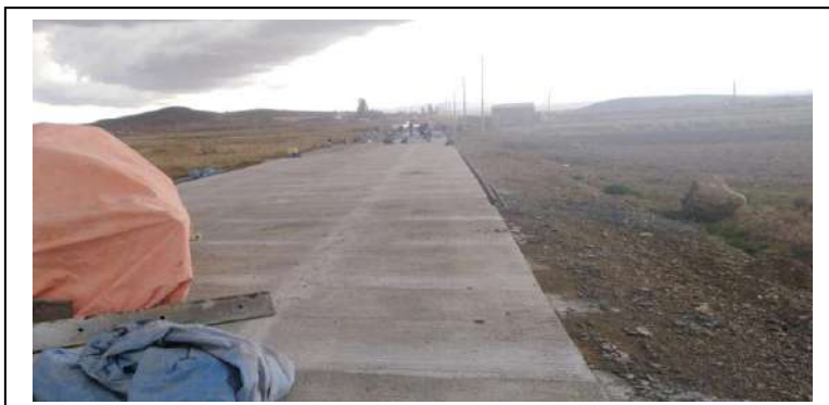
IMAGEN 3: APLICACIÓN DE HORMIGON
