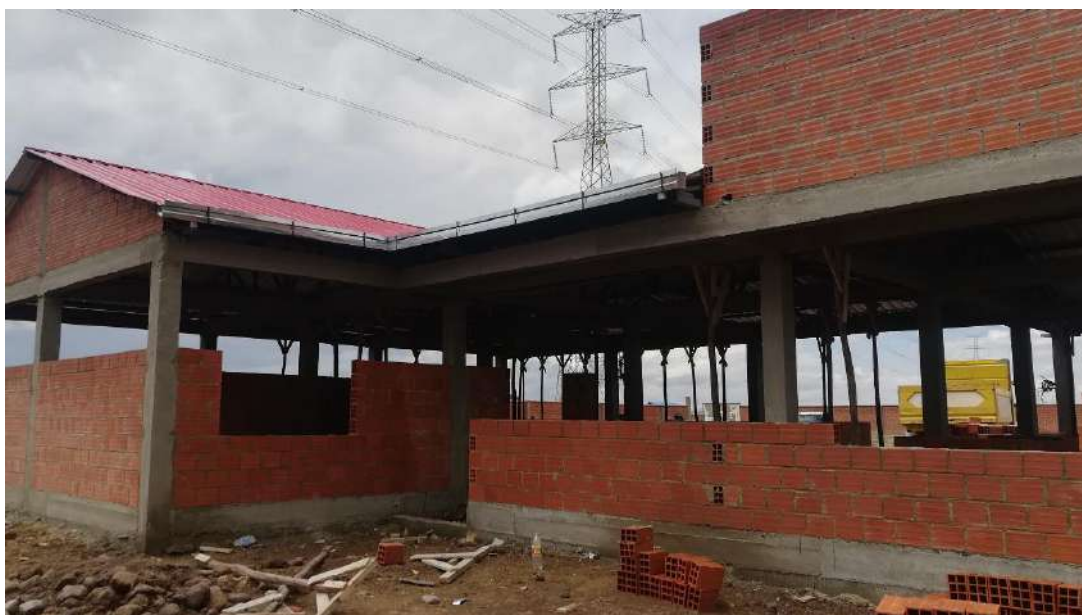
IMAGEN 2: MURO DE LADRILLO DE 6H E=0.12 M.
