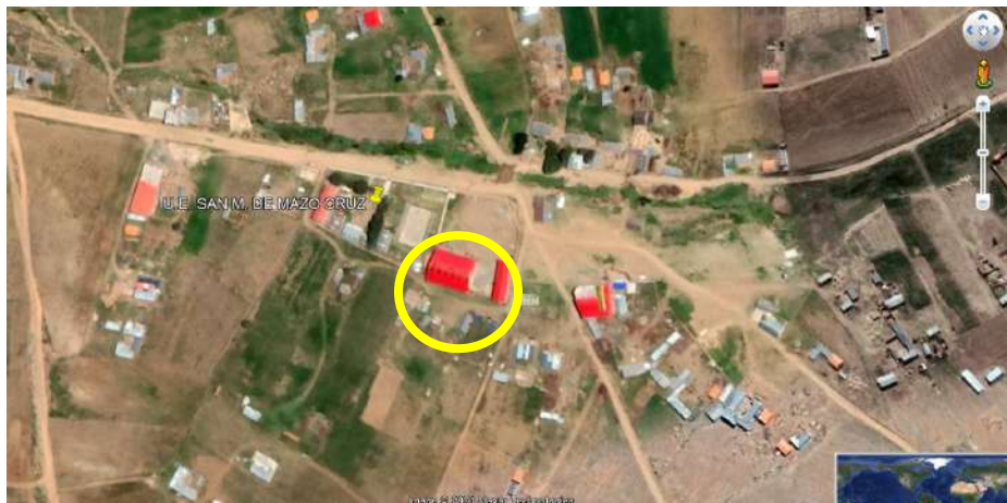
IMAGEN 2: VISTA EN PERSPECTIVA (Obra al 50%)
