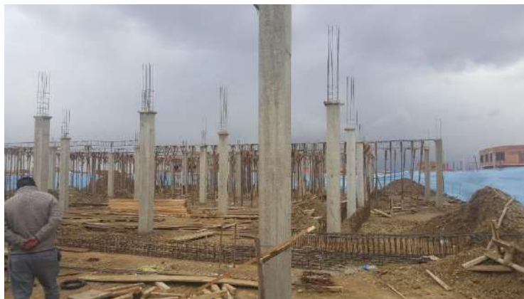
IMAGEN 1: ZAPATAS Y COLUMNAS DE H° A°
