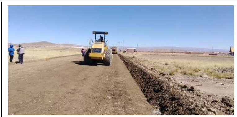
IMAGEN 2: PLATAFORMA EN CONFORMACION
