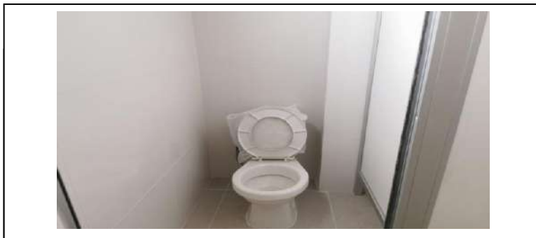
IMAGEN 3: Construcción de baños en el área de DOT`S (Obra Concluida)
