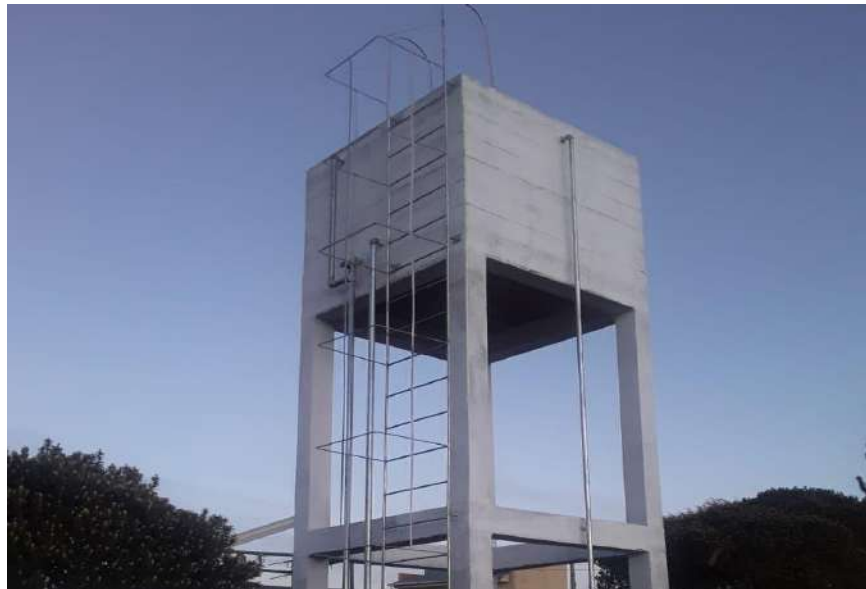
IMAGEN 1: CONSTRUCCIÓN TANQUE DE AGUA CENTRO DE SALUD HILATA CENTRO
