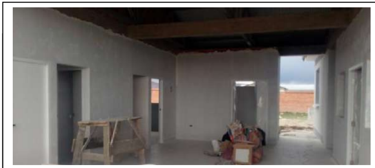
IMAGEN 3: Construcción pintura interior (Obra Concluida)
