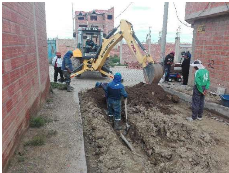
IMAGEN 2: TENDIDO DE TUBERIA Y RELLENO MATERIAL COMUN
