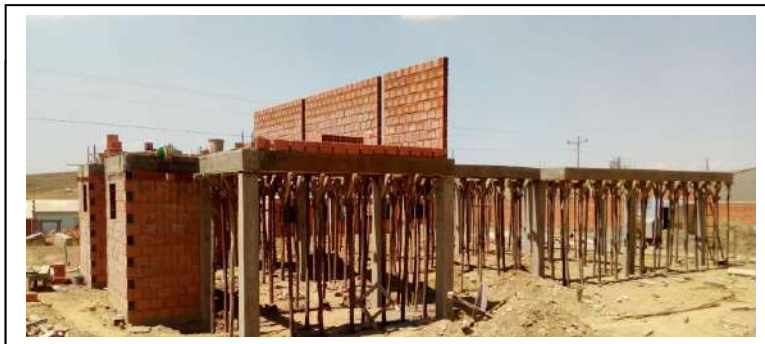
IMAGEN 2: la Construcción de vigas y muros (Obra al 50%)
