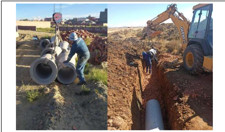
IMAGEN 2: TENDIDO DE TUBERÍAS
