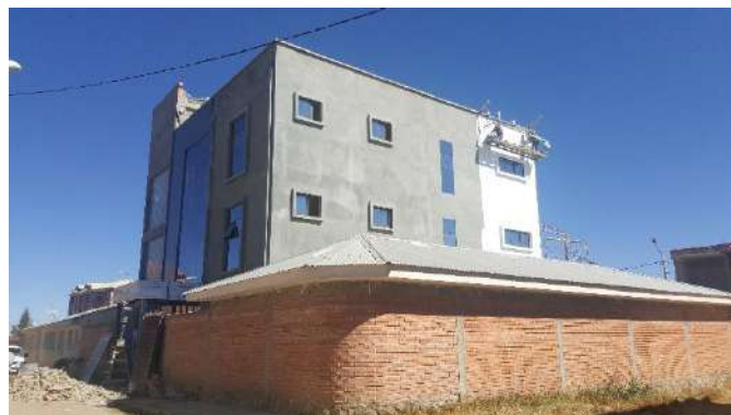
IMAGEN 3: REVOQUE EXTERIOR, VENTANAS, FACHADA FLOTANTE Y PINTURA
