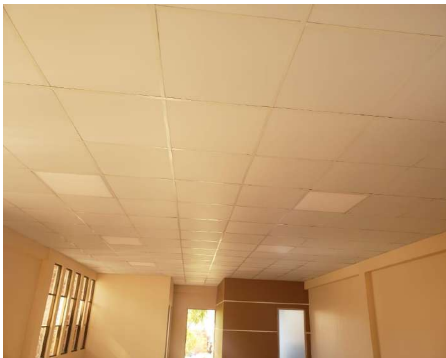
IMAGEN 2: PINTURA SATINADA EN INTERIORES (DOS MANOS)
