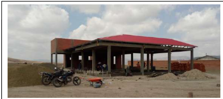
IMAGEN 3: Construcción de la cubierta (Obra Concluida)
