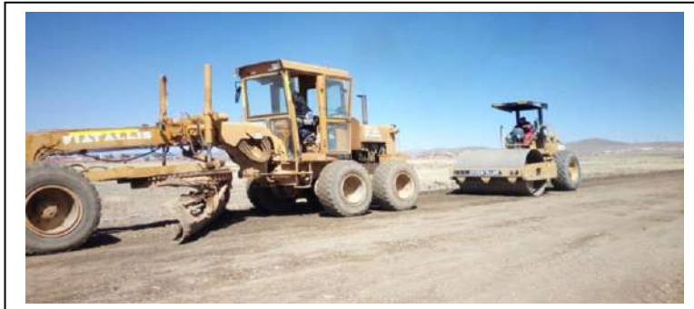
IMAGEN 1: MAQUINARIA COMPACTANDO CICLOVIA
