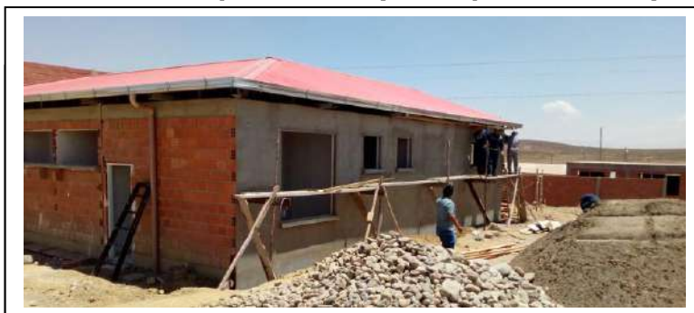
IMAGEN 3: Construcción revoque interior y revoque exterior (Obra Concluida)
