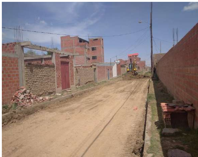
IMAGEN 1: CORTE DE DE MATERIAL ARCILLOSO
