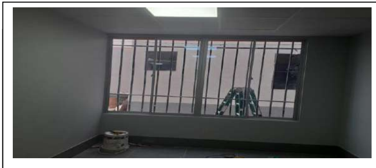
IMAGEN 2: Construcción de pintura y zócalos (Obra al 50%)
