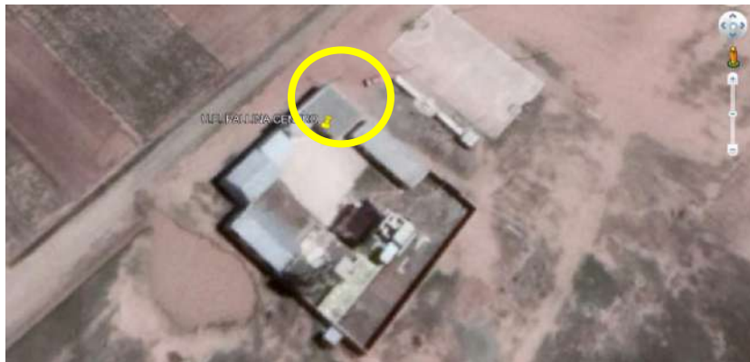
IMAGEN 2: VISTA EN PERSPECTIVA (Obra al 50%)
