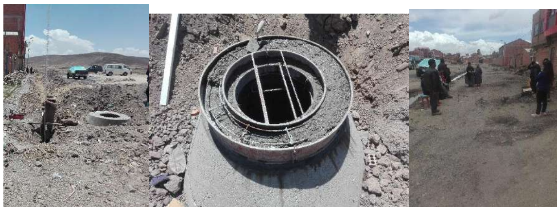
IMAGEN 2: CAMARAS DE INSPECCION Y LIMPIEZA.
