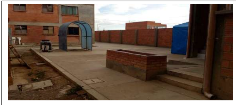
IMAGEN 1: Construcción del área de TRIAGE (Inicio de Obra)
