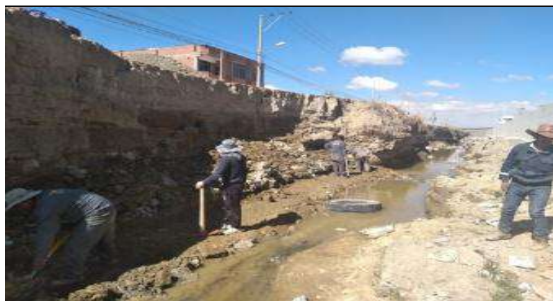
IMAGEN 2: CONFORMADO DEFENSIVO CON NEUMATICO RECICLADO (D=1000 MM) H=2.50 M
