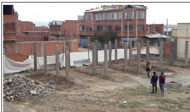
IMAGEN 3: Vaciado de columnas
