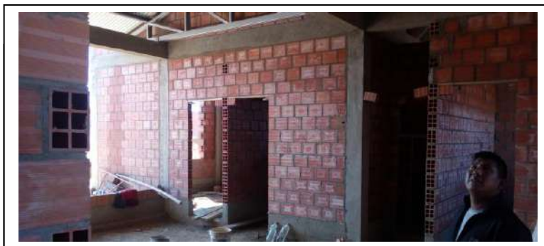
IMAGEN 2: la Construcción de muros interiores (Obra al 100%)
