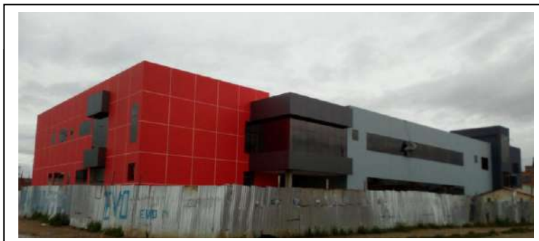
IMAGEN 3: fachada principal ya concluida (Obra Concluida)
