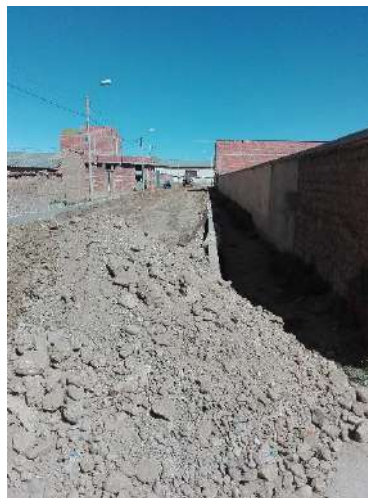
IMAGEN 2: TENDIDO Y RELLENO CON MATERIAL COMUN
