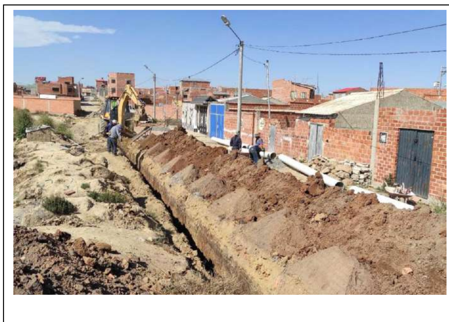
IMAGEN 2: EXCAVACIÓN DE ZANJA Y TENDIDO DE TUBERÍA
