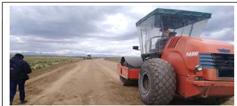
IMAGEN 2: CONFORMACION DE PLATAFORMA
