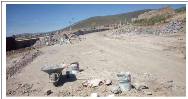
IMAGEN 1: INICIO DE MANO DE OBRA
