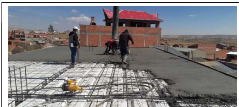
IMAGEN 3: Vaciado de losa (Obra Concluida)
