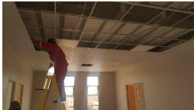
IMAGEN 1: INSTALACIONES Y CIELO FALSO
