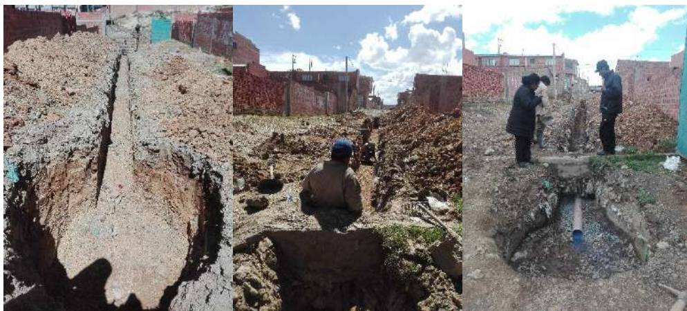
IMAGEN 2: CAMARAS DE INSPECCION Y LIMPIEZA.
