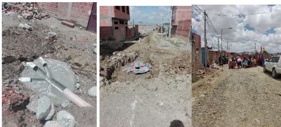
IMAGEN 2: CAMARAS DE INSPECCION Y LIMPIEZA.
