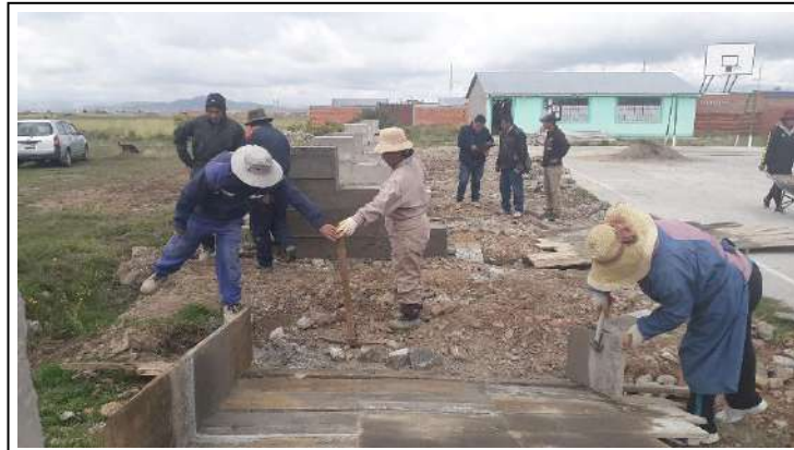
IMAGEN 2: Muro de hormigón ciclópeo para colocado de malla olímpica Urb. Santa Rita
