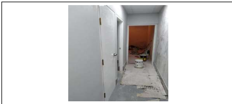
IMAGEN 1: Construcción de pisos y paredes (Inicio de Obra)
