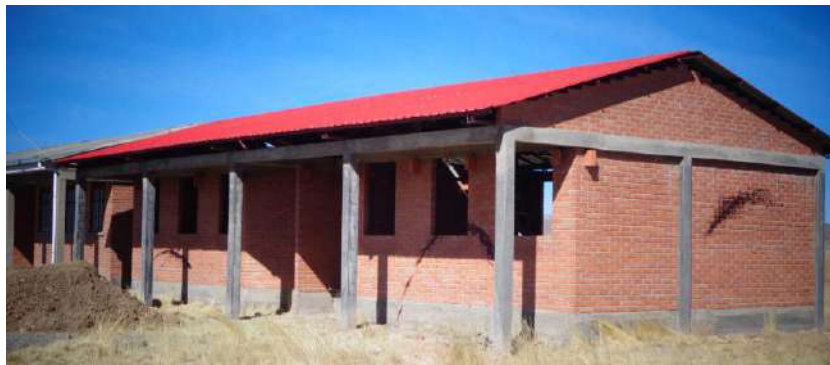
IMAGEN 2: VISTA EN PERSPECTIVA (Obra al 50%)
