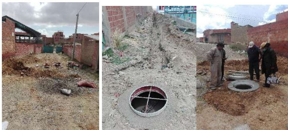
IMAGEN 2: CAMARAS DE INSPECCION Y LIMPIEZA.
