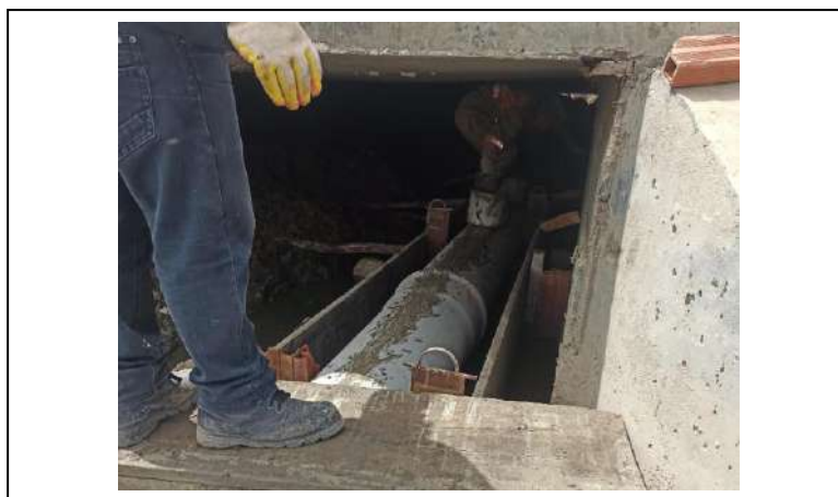
IMAGEN 1: TENDIDO DE TUBERÍA
