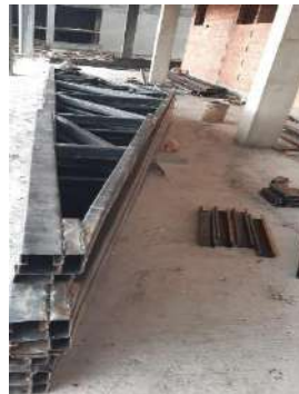
IMAGEN 2: MONTADO Y TECHADO CALAMINA TRAPEZOIDAL
