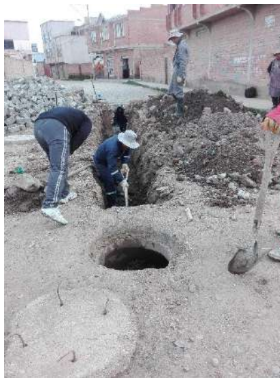
IMAGEN 2: RELLENO, COMPACTADO Y REAPRACION CAMARA
