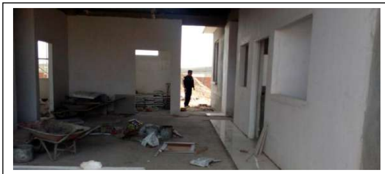
IMAGEN 1: Construcción de pintura interior y puertas (Inicio de Obra)
