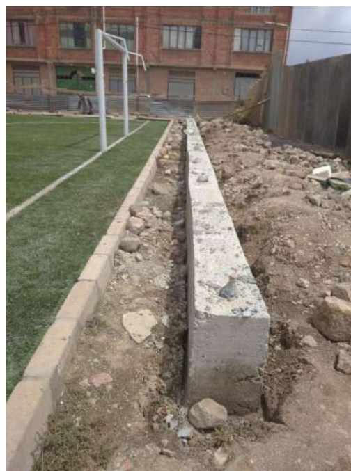
IMAGEN 2: CIMIENTO DE HORMIGÓN CICLÓPEO
