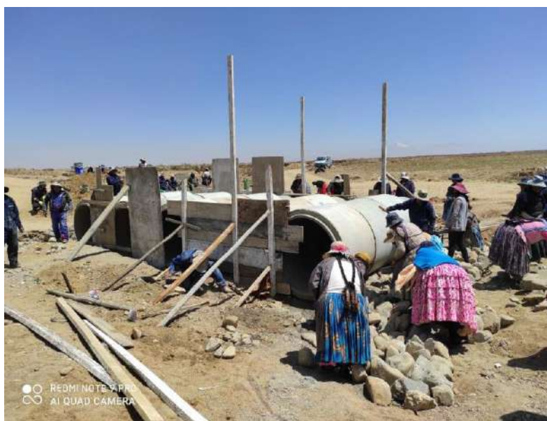
IMAGEN 1: CONSTRUCCIÓN PUENTE VEHICULAR
