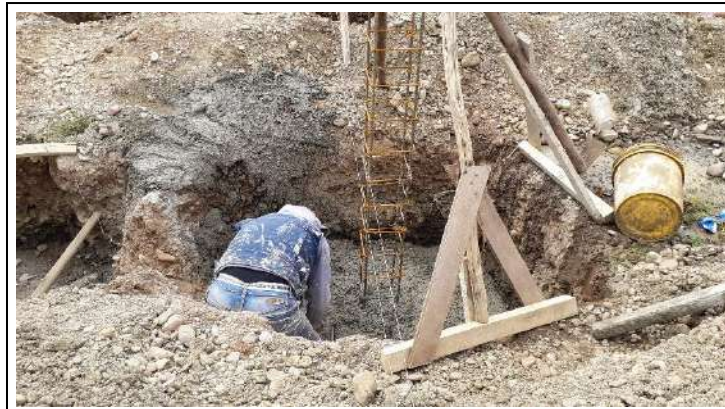
IMAGEN 2: Vaciado de zapatas y armado de columnas
