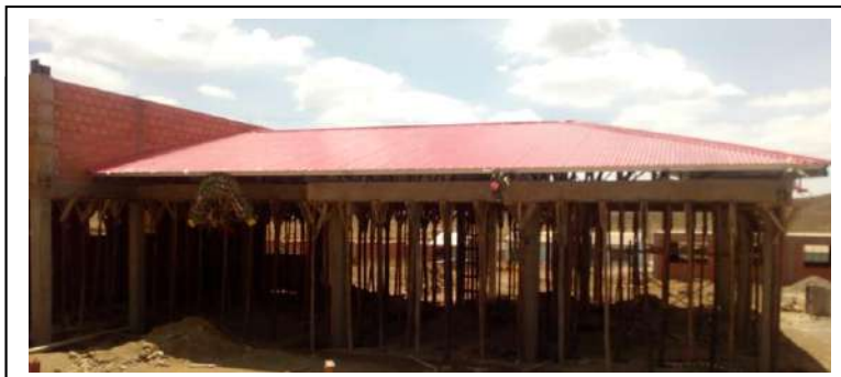
IMAGEN 3: Construcción de la cubierta (Obra Concluida)
