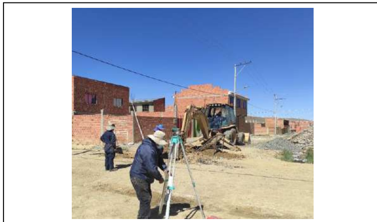
IMAGEN 1: TRAZADO Y REPLANTEO
