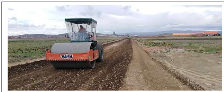
IMAGEN 2: PLATAFORMA EN CONFORMACION
