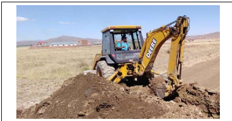
IMAGEN 1: REMOCION DE MATERIAL PARA DEFENSIVOS
