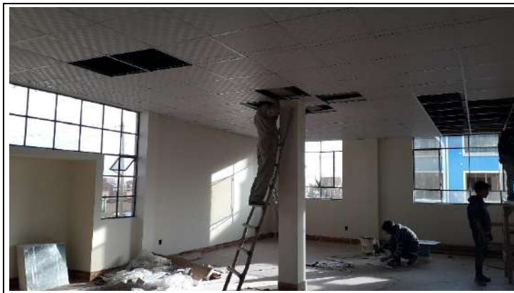
IMAGEN 1: Colocado de cielo falso plafón, sala de reuniones
