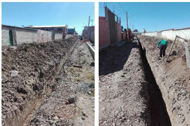
IMAGEN 2: TENDIDO Y RELLENO CON MATERIAL COMUN
