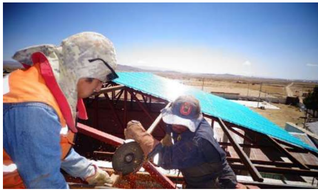
IMAGEN 2: VISTA EN PERSPECTIVA (Obra al 50%)
