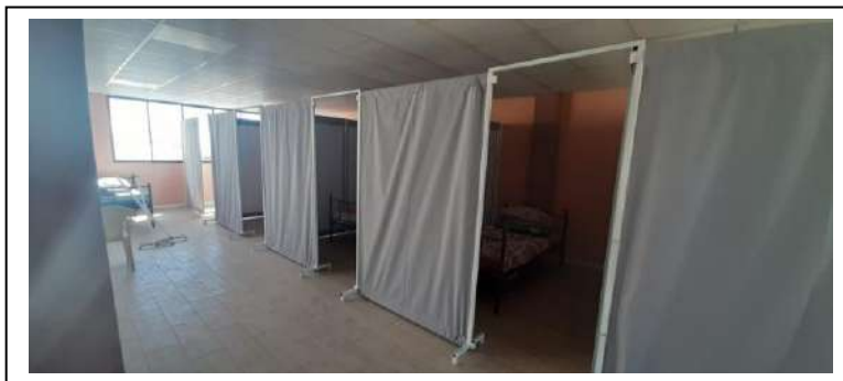
IMAGEN 1: Implementación de biombos (Inicio de Obra)
