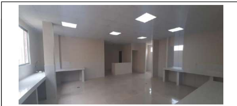
IMAGEN 2: la cocina del comedor terminado (Obra al 50%)
