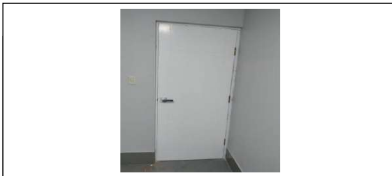
IMAGEN 3: Construcción y colocado de puertas (Obra Concluida)
