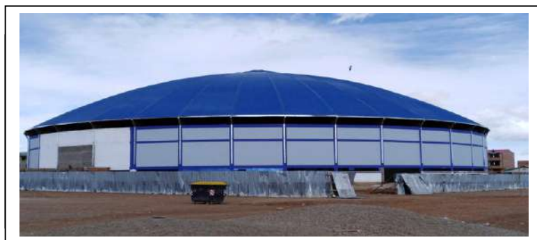
IMAGEN 3: NIVELADO DE TERRENO VACIADO DE ACERA PROSCENIO PINTURA, REVOQUE, COLCOADOD E VENTANAS
