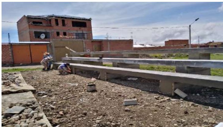
IMAGEN 1: Construcción de graderías en la Urb. Complemento Nuevo Esperanza
