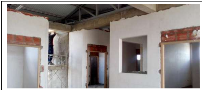
IMAGEN 1: Revoque interior y colocado de marcos de puerta (Inicio de Obra)
