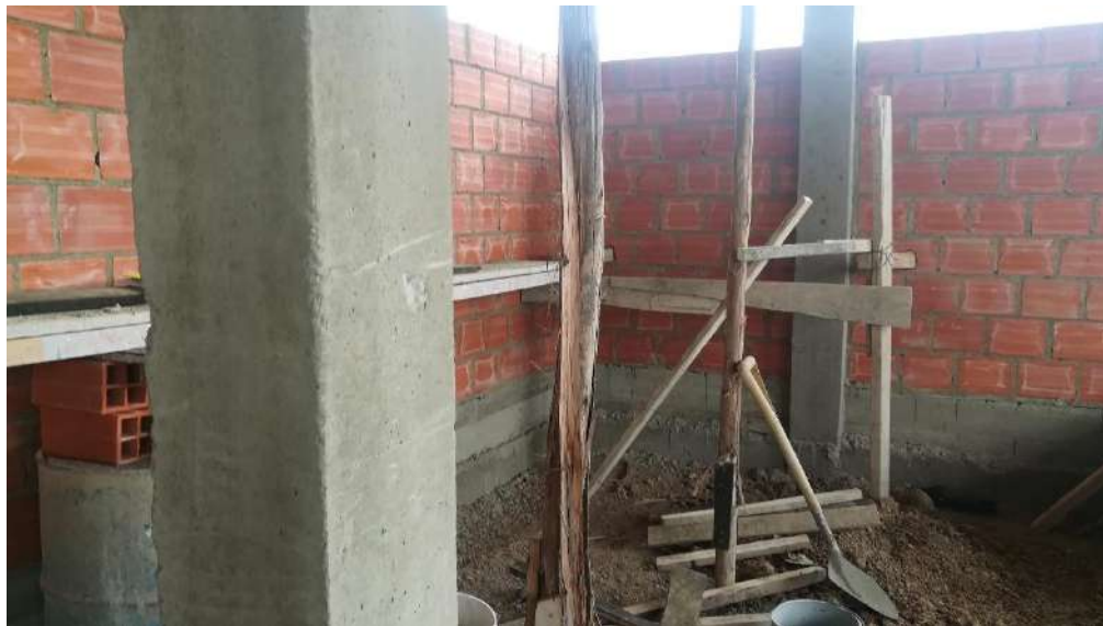
IMAGEN 1: CIMIENTO Y SOBRECIMIENTO DE H°Cº
