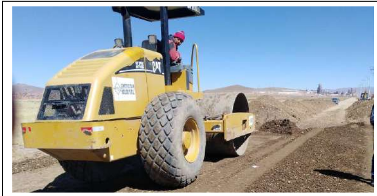
IMAGEN 1: INICIO DE LA CONFORMACION
