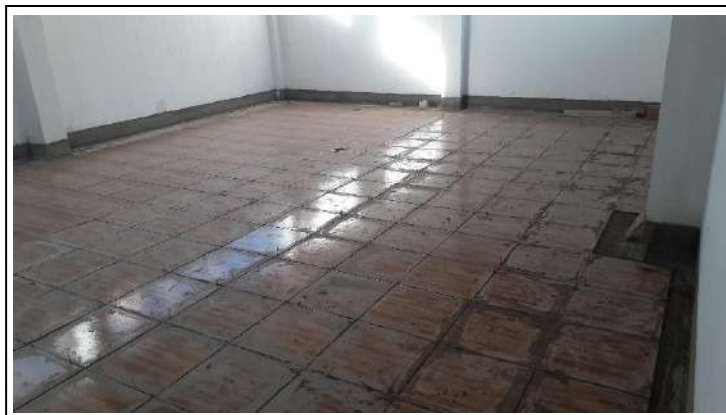
IMAGEN 1: colocado Piso de Cerámica
