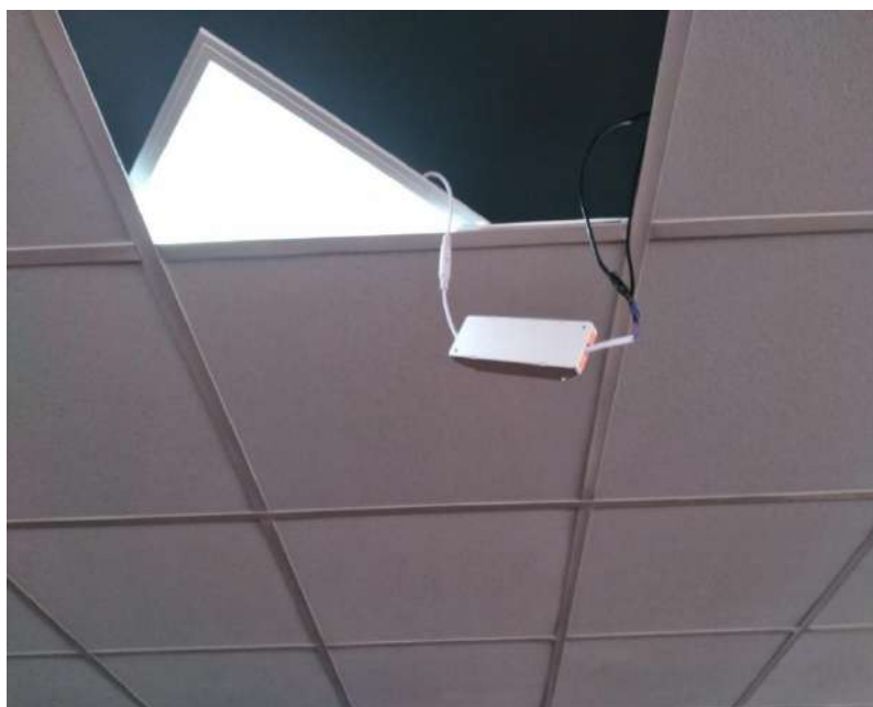
IMAGEN 1: PLACAS DE CIELO FALSO 1ER PISO
