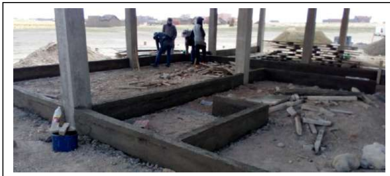
IMAGEN 1: Construcción de cimientos (Inicio de Obra)
