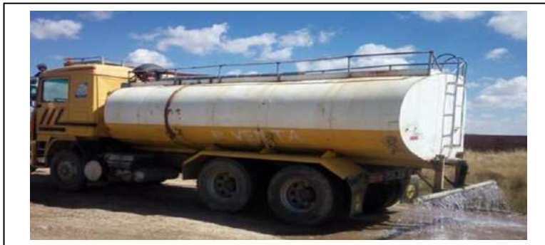
IMAGEN 1: REGADO DEL TRAMO "C" FASE 3 CON CISTERNA
