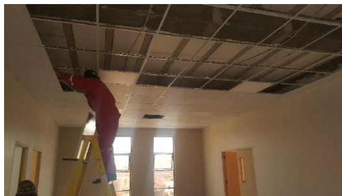
IMAGEN 1: INSTALACIONES Y CIELO FALSO
