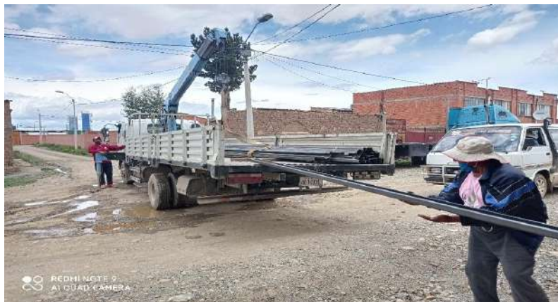
IMAGEN 1: Perfil costanera 100x50x15x2mm (barra=6m)
