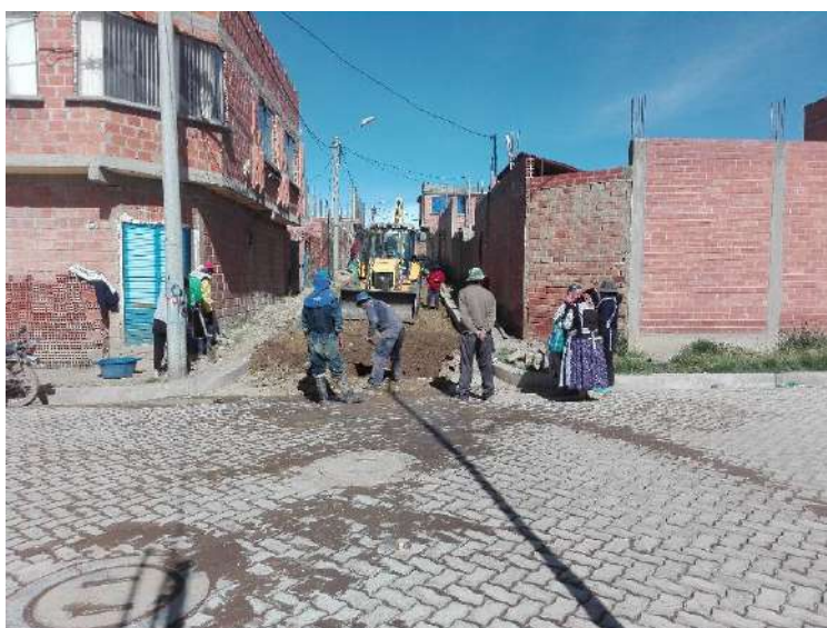
IMAGEN 2: TENDIDO DE TUBERIA Y RELLENO MATERIAL COMUN
