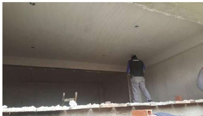
IMAGEN 3: REVOQUE INTERIOR DE YESO
