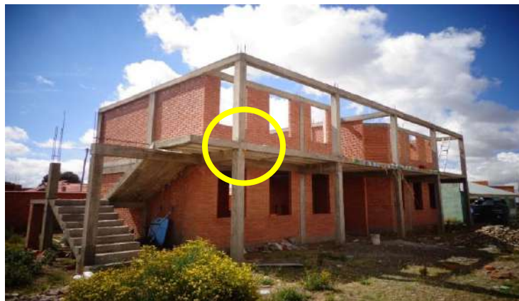
IMAGEN 2: VISTA EN PERSPECTIVA (Obra al 50%)
