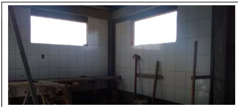
IMAGEN 2: Construcción de revestimiento en paredes (Obra al 50%)
