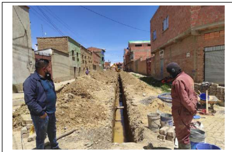
IMAGEN 2: EXCAVACIÓN DE ZANJA
