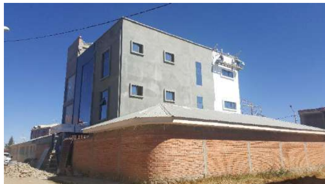
IMAGEN 3: REVOQUE EXERIOR, VENTANAS, FACHADA FLOTANTE Y PINTURA
