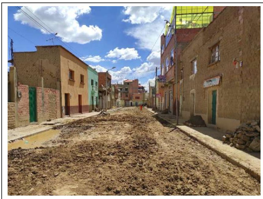
IMAGEN 2: LIMPIEZA Y RETIRO DE ESCOMBROS
