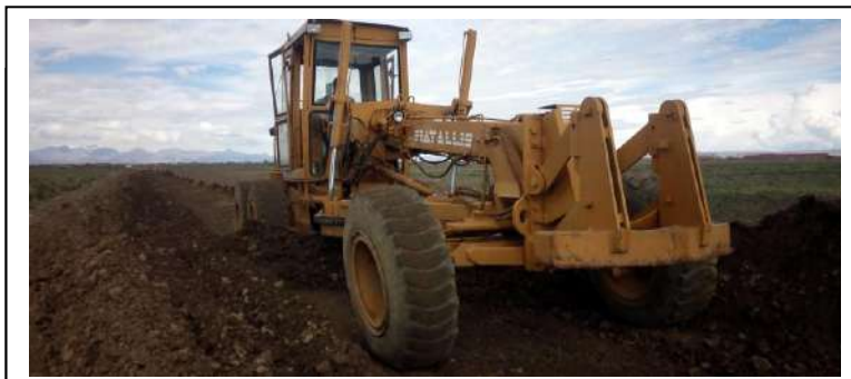
IMAGEN 2: CONFORMACION DE CICLOVIA
