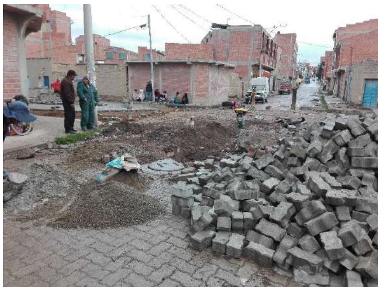
IMAGEN 2: RELLENO, COMPACTADO Y REAPRACION CAMARA
