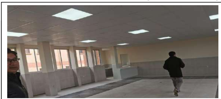
IMAGEN 3: El comedor concluido (Obra Concluida)
