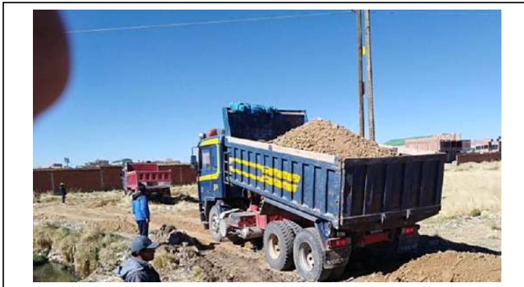
IMAGEN 2: ACAMELLONADO DE MATERIAL
