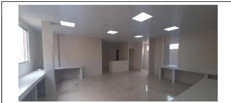
IMAGEN 2: la cocina del comedor terminado (Obra al 50%)
