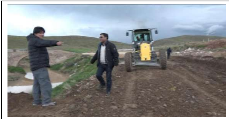
IMAGEN 1: INICIO DE OBRA
