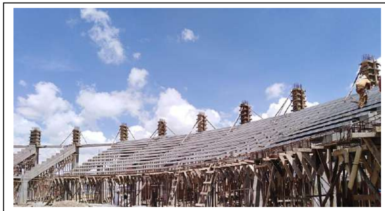
IMAGEN 2: VACIADO DE GRADERIAS
