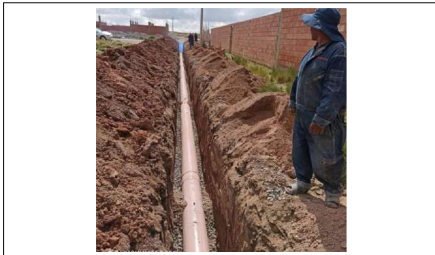
IMAGEN 1: INSPECCION Y TENDIDO DE TUBERIA
