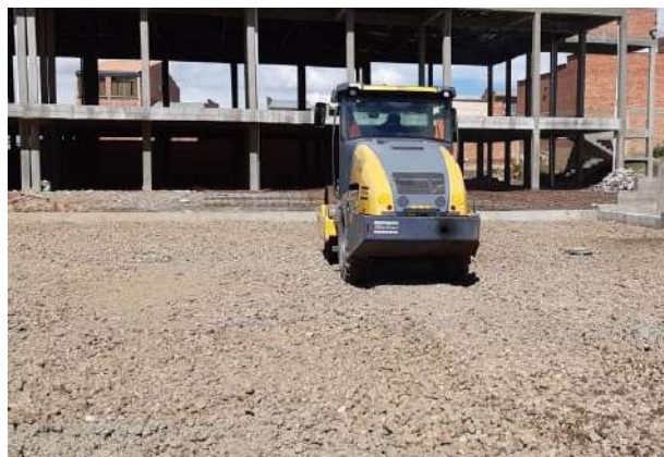
IMAGEN 3: COMPACTACIÓN DE PLATAFORMA
