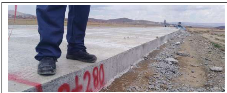
IMAGEN 3: APLICACIÓN DE HORMIGON
