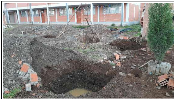
IMAGEN 1: Excavación de zapatas (nivel freático alto)
