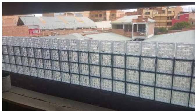
IMAGEN 2: MURO DE BLOQUES DE VIDRIO
