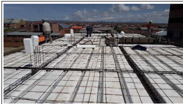
IMAGEN 2: Armado de vigas de encadenado para posterior vaciado de losa
