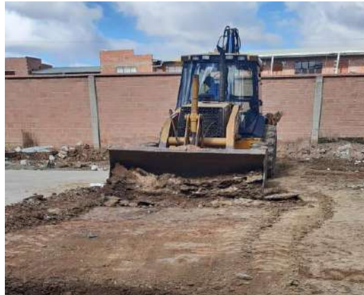
IMAGEN 2: CONFORMACIÓN Y NIVELACIÓN
