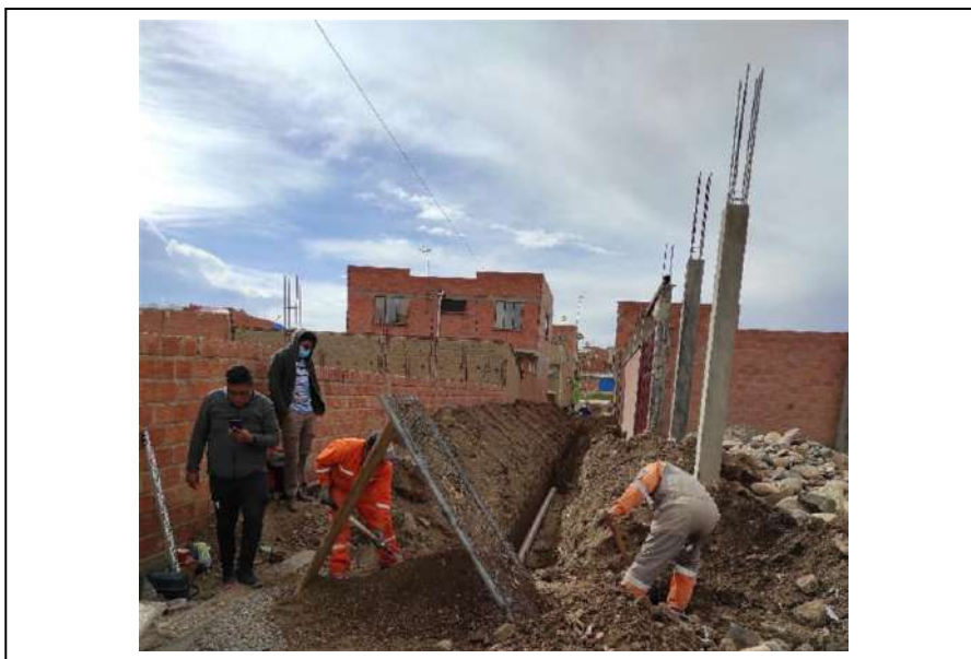
IMAGEN 1: EXCAVACIÓN Y TENDIDO DE TUBERÍA
