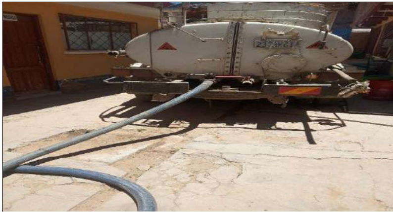
IMAGEN 2: Limpieza de pozos séptico U.E. Viliroco
