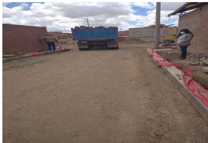
IMAGEN 2: PLATAFORMA CONFORMADA
