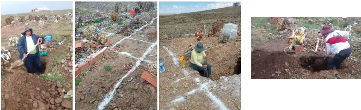
EXCAVACION DE FOSAS MANUAL
