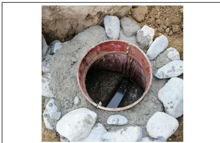
IMAGEN 2: CONSTRUCCIÓN DE CÁMARA
