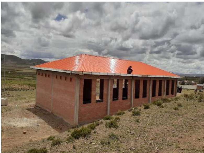
IMAGEN 1: CONSTRUCCIÓN CASA CULTURAL
