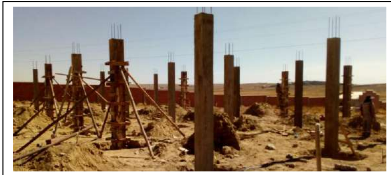
IMAGEN 1: Construcción de columnas (Inicio de Obra)
