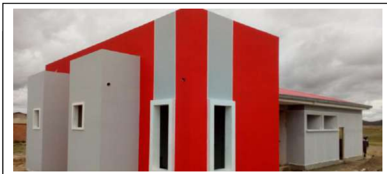
IMAGEN 2: Construcción pintura exterior (Obra al 50%)
