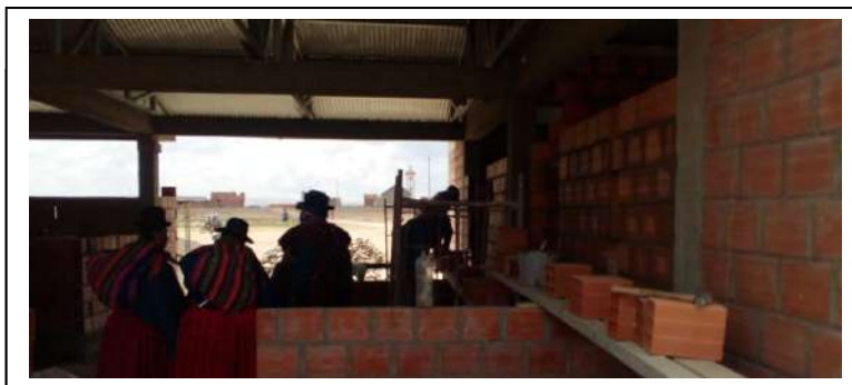
IMAGEN 2: Construcción de muros (Obra al 50%)
