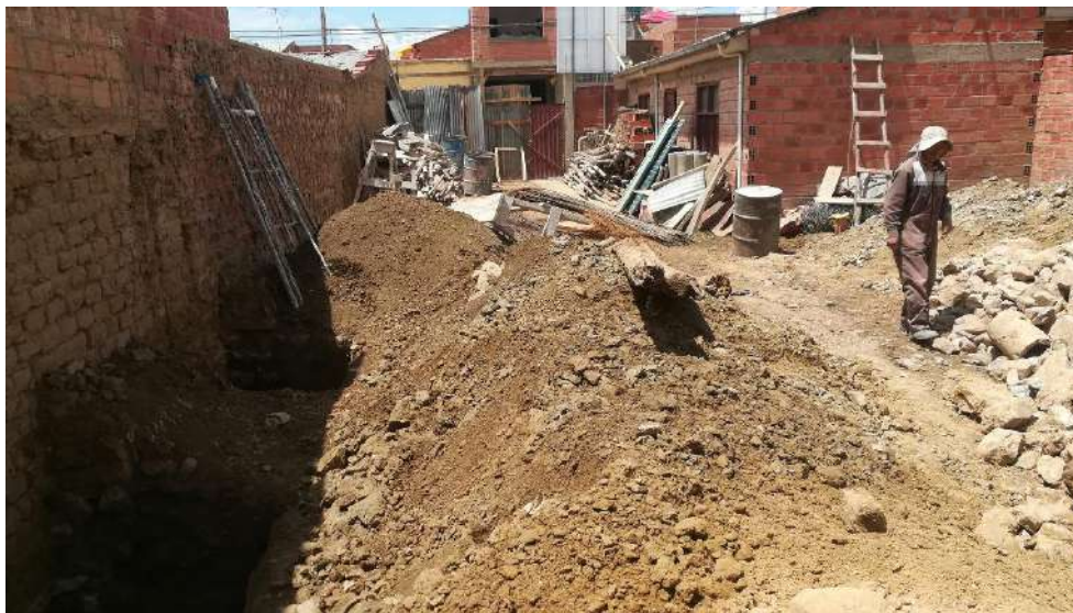
IMAGEN 2: EXCAVACIÓN 0-2.00 M. S/AGOTAMIENTO
