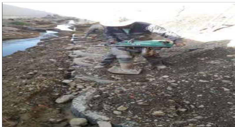
IMAGEN 3: CONFORMADO Y COMPACTADO
