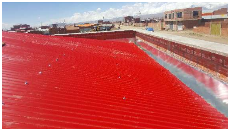
IMAGEN 3: CUBIERTA DE CALAMINA GALVANIZADA Y PARAPETO CON BOTAGUAS
