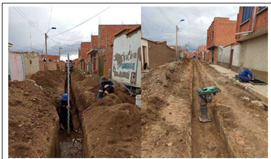
IMAGEN 2: NIVELACION Y COMPACTADO
