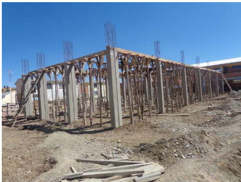
IMAGEN 1: COLUMNAS DE HORMIGÓN ARMADO H-21
