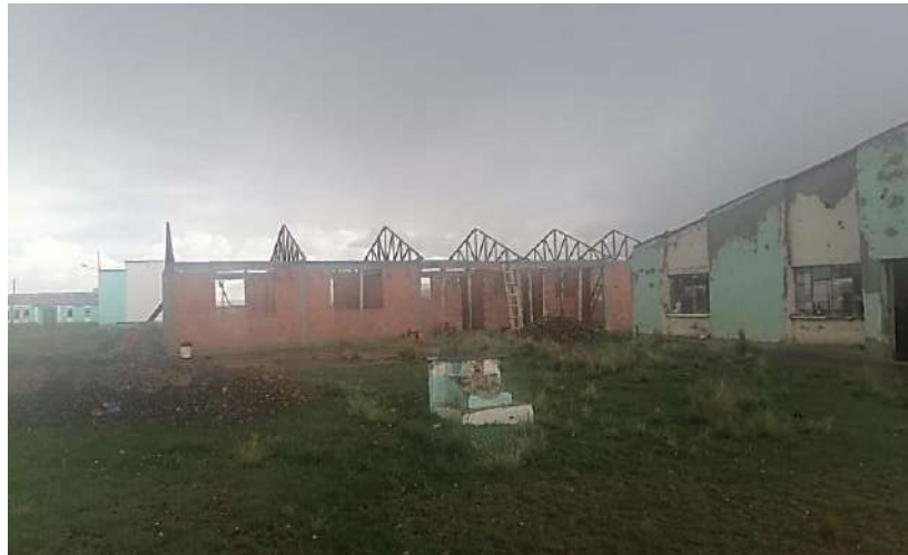
IMAGEN 1: CONSTRUCCIÓN TINGLADO SALA DE LABORATORIO U.E JOSE BALLIVIAN DE HICHURAYA
