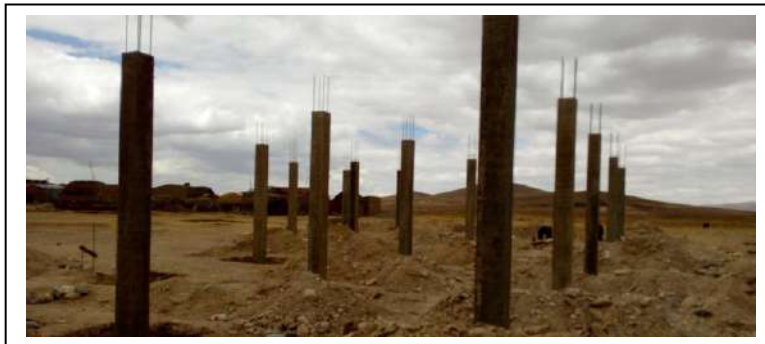
IMAGEN 1: Construcción de columnas (Inicio de Obra)
