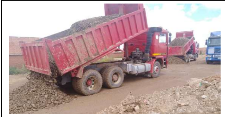
IMAGEN 1: ACAMELLONADO DE MATERIAL ARIDO
