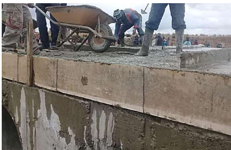
IMAGEN 2: CONSTRUCCIÓN PUENTE VEHICULAR
