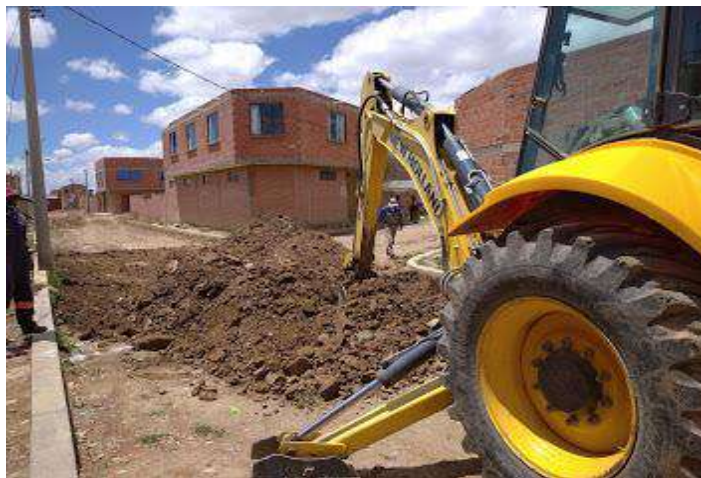
IMAGEN 1: CORTE DE DE MATERIAL ARCILLOSO
