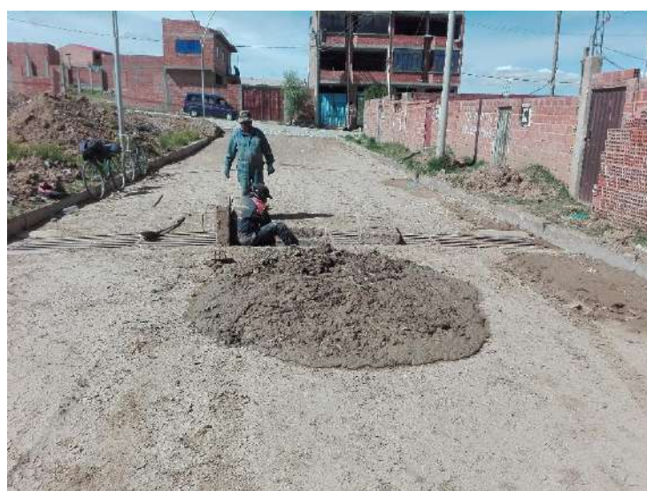
IMAGEN 2: EXTRACCION DE MATERIAL SEDIMENTADO
