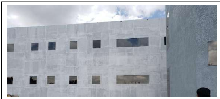
IMAGEN 1: La primera mano de la fachada (Inicio de Obra)
