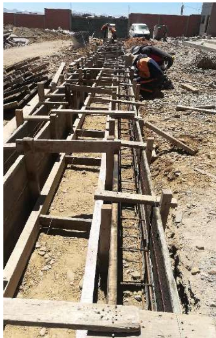
IMAGEN 2: BORDILLOS PARA PARQUEO VEHICULAR
