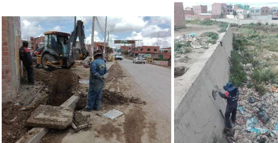
IMAGEN 2: PERFILADO TENDIDO DE TUB.
