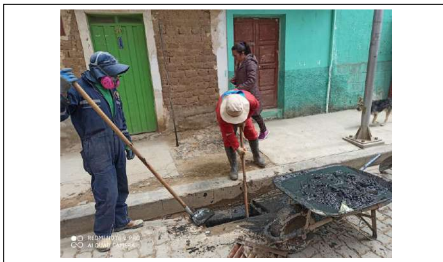
IMAGEN 1: LIMPIEZA Y CAMBIO DE TAPAS DE SUMIDEROS
