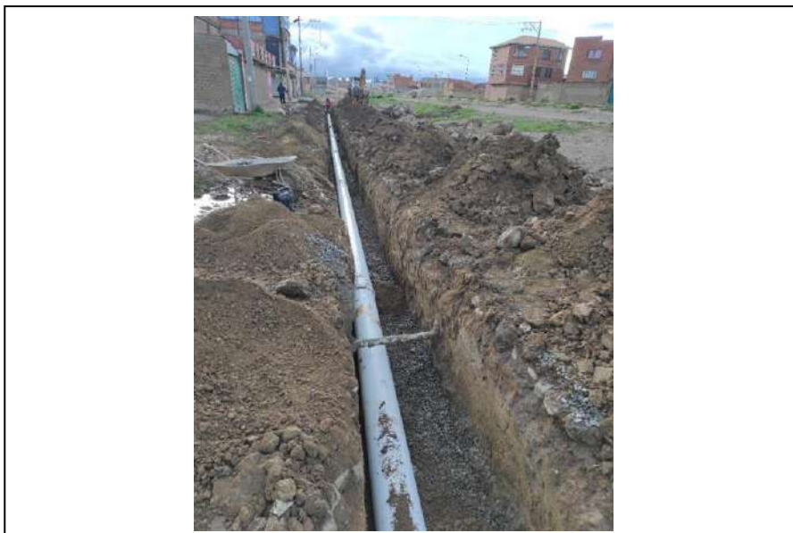
IMAGEN 2: TENDIDO DE TUBERÍA
