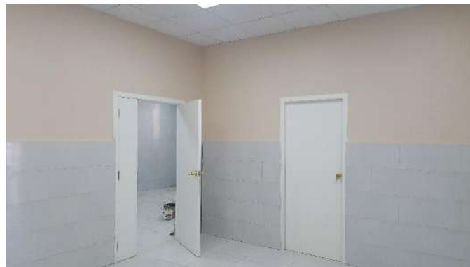
IMAGEN 2: REVOQUES, REVESTIMIENTOS, PINTURA Y PUERTAS
