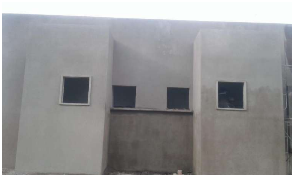
IMAGEN 2: REVOQUE EXTERIOR DE CEMENTO
