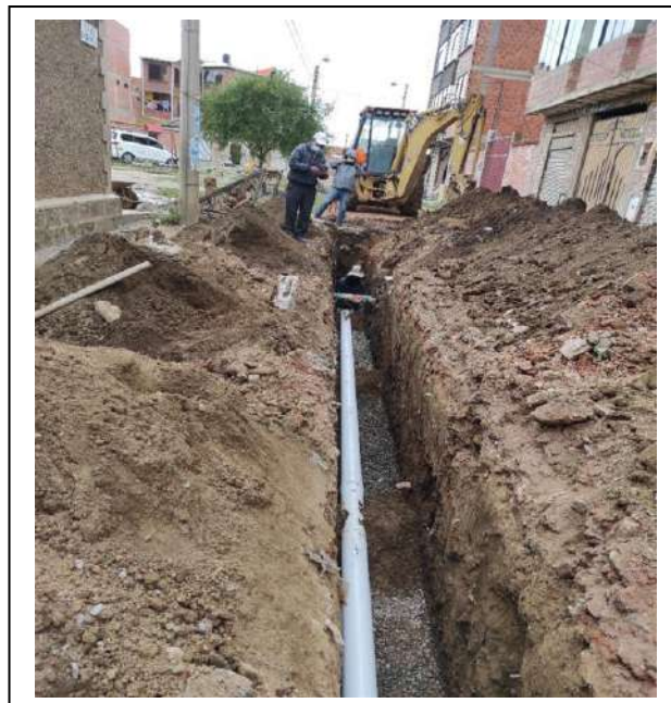
IMAGEN 2: EXCAVACIÓN Y TENDIDO DE TUBERÍA
