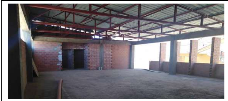
IMAGEN 1: el comedor en obra gruesa (Inicio de Obra)
