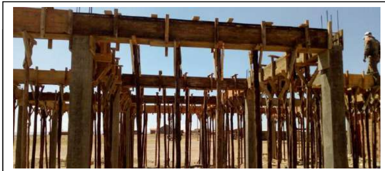
IMAGEN 2: la Construcción de vigas (Obra al 50%)
