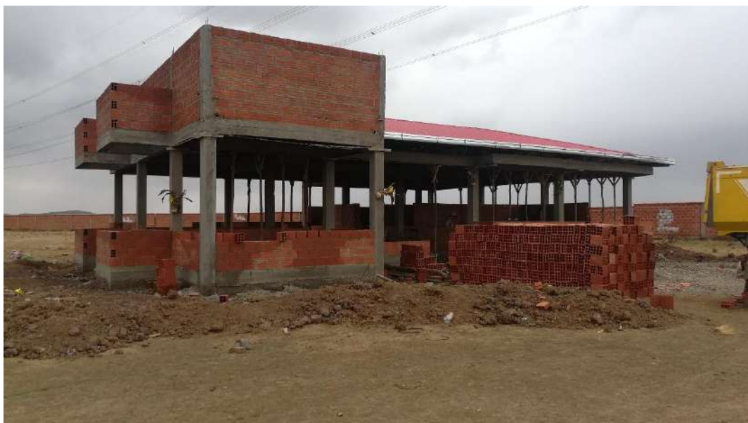
IMAGEN 2: CUBIERTA DE CALAMINA GALVANIZADA + ESTRUCTURA METÁLICA
