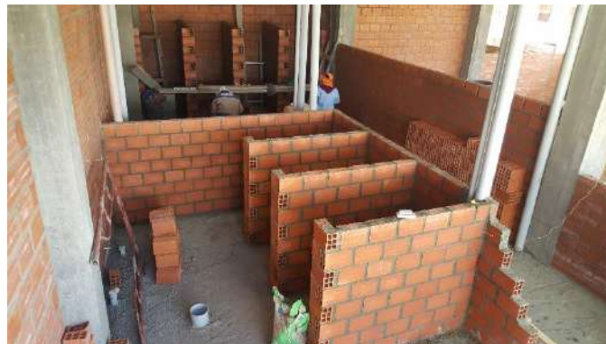
IMAGEN 1: MUROS DE LADRILLO
