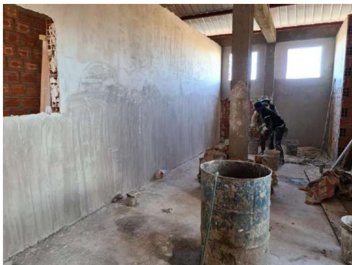
IMAGEN 2: REVOQUE INTERIOR DE YESO SOBRE MURO
