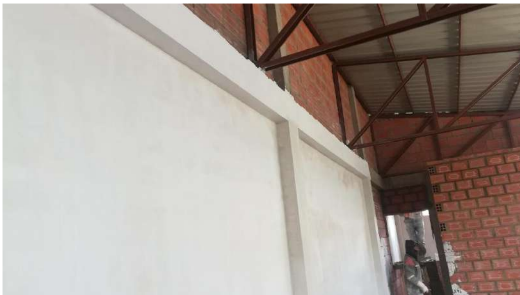
IMAGEN 1: REVOQUE INTERIOR DE YESO EN MUROS
