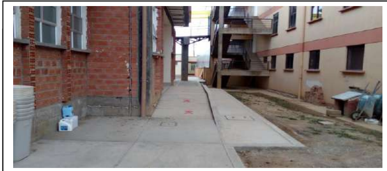
IMAGEN 2: Construcción de aceras y rampas (Obra al 50%)
