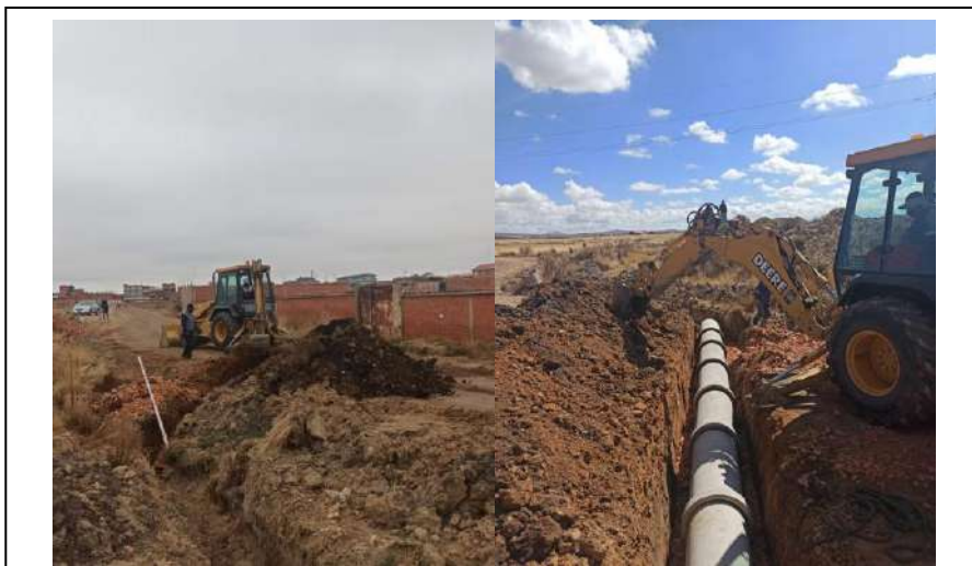
IMAGEN 2: TENDIDO DE TUBERÍAS
