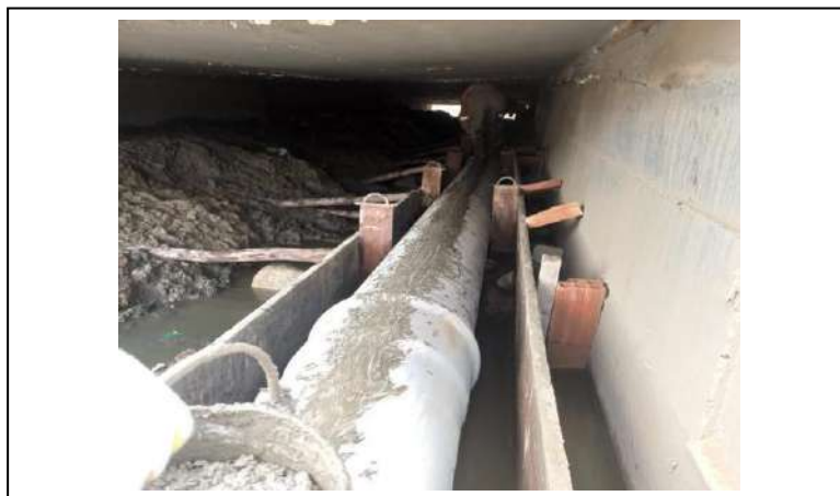
IMAGEN 2: ENCAMISADO DE HORMIGÓN
