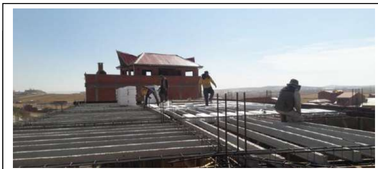
IMAGEN 2: Armado de la losa (Obra al 50%)
