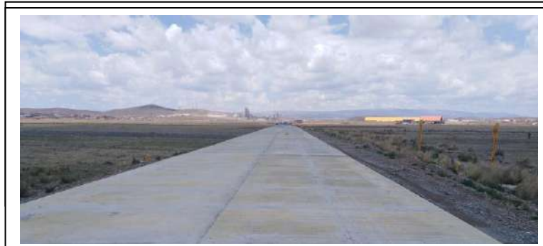
IMAGEN 3: APLICACIÓN DE HORMIG
