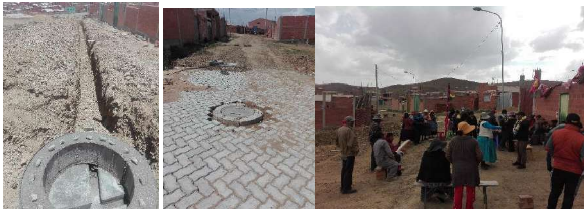
IMAGEN 2: CAMARAS DE INSPECCION Y LIMPIEZA.
