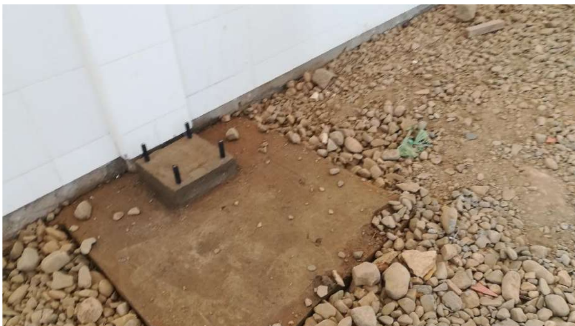
IMAGEN 2: ZAPATAS DE HORMIGÓN P/ PÓRTICO METÁLICO
