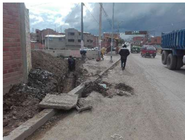
IMAGEN 2: PERFILADO TENDIDO DE TUB.
