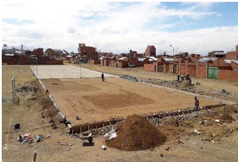
Conformación de plataforma con material seleccionado Urb. José Ballivian "B" DISTRITO 6
