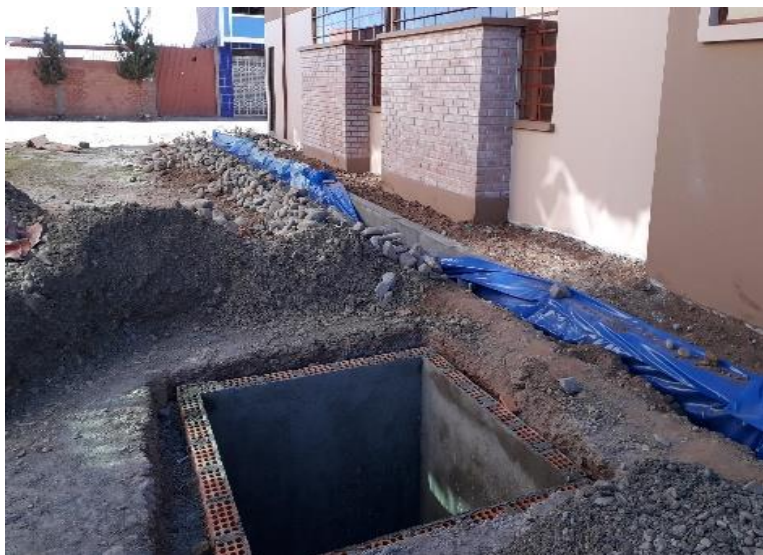
Construcción de pozo séptico Urb. José Ballivian "B" DISTRITO 6
