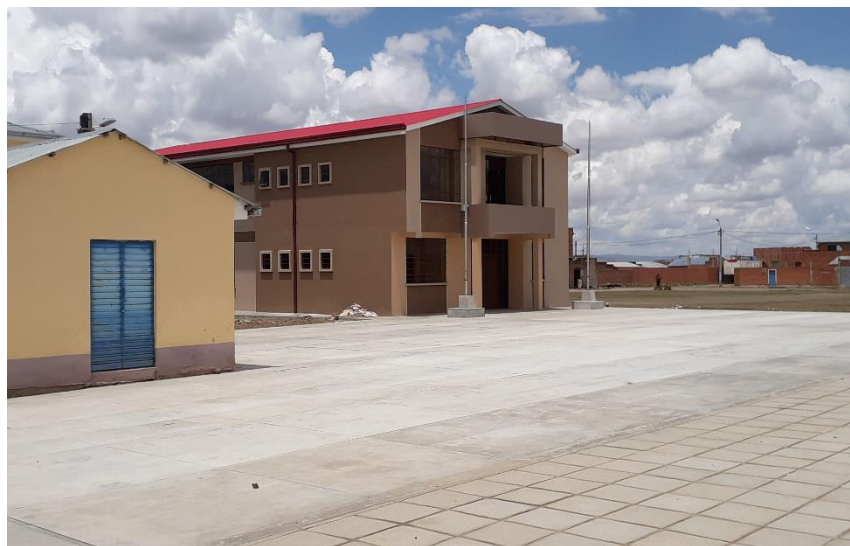
Vaciado de carpeta de hormigón E=5cm y relleno de juntas de dilatación Urb. José Ballivian "B" DISTRITO 6
