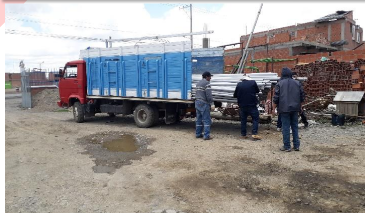
Compra de materiales Agua Potable tubería PVC E-40 D=2"
