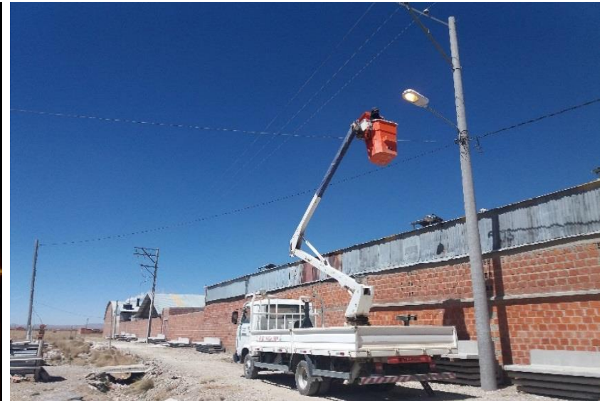
Mantenimiento de la red de alumbrado Publio Urb. 15 de Noviembre DISTRITO 6
