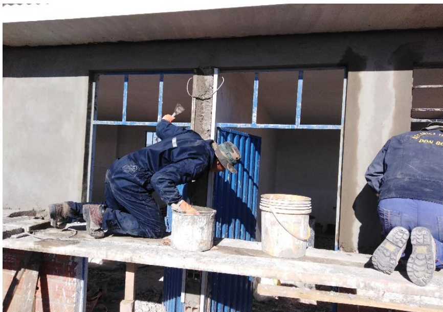
REVOQUE DE MORTERO, YESO INTERIOR U.E. BATALLA ALTO DE LA ALIANZA
