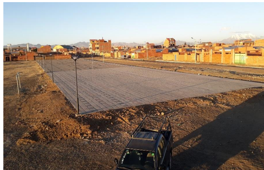
Acabado del colocado de baldosas prefabricadas Urb. José Ballivian "B" DISTRITO 6
