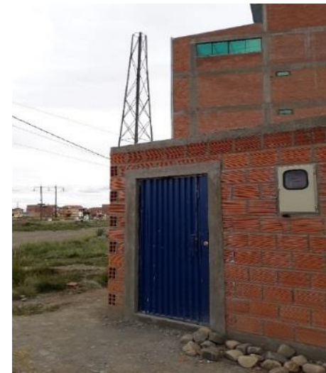
Instalación de caja de medidor DISTRITO 6
