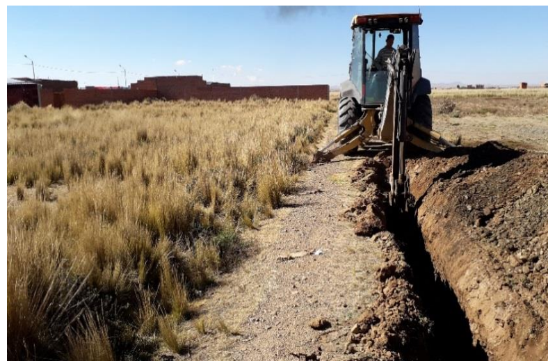
Excavación de zanja para tendido de tubería de PVC DISTRITO 6
