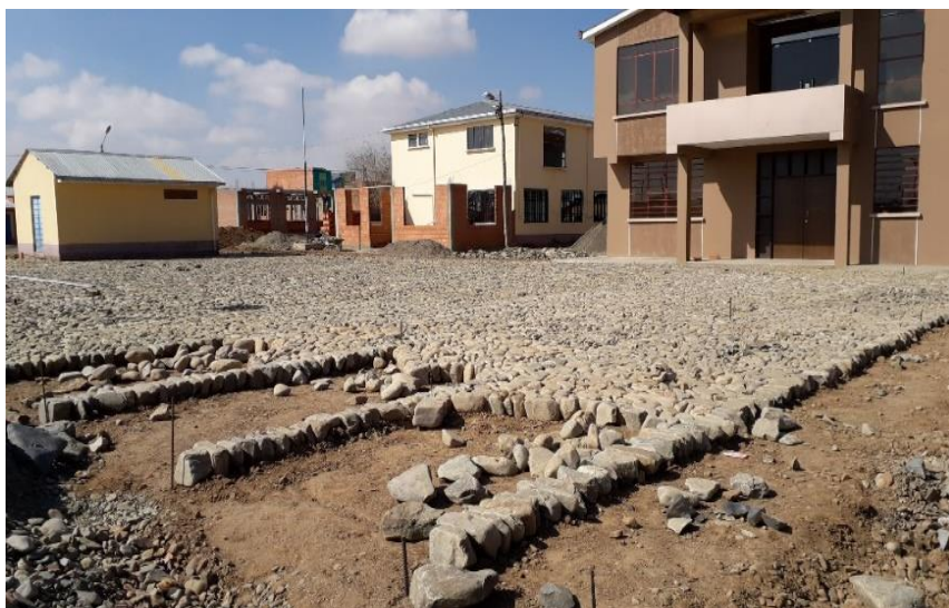
Conformación y empedre de plataforma Urb. José Ballivian "B" DISTRITO 6
