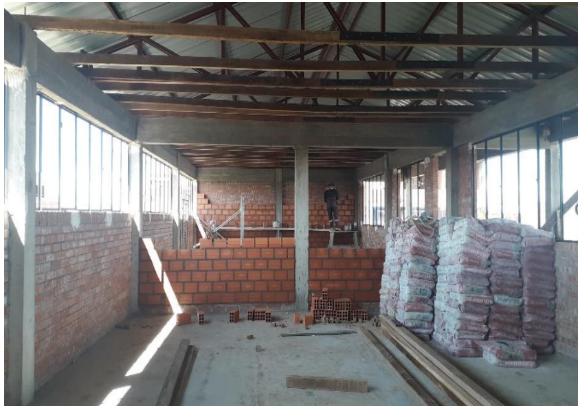
CONSTRUCCIÓN DE MURO DE LADRILLO U.E. HUGO BANZER SUAREZ
