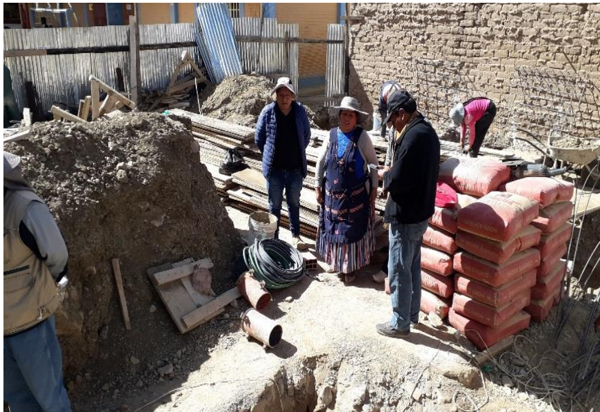
INSPECCIÓN, EXCAVACIÓN Y VACIADO DE CARPETA DE NIVELACIÓN U.E. LA FLORIDA
