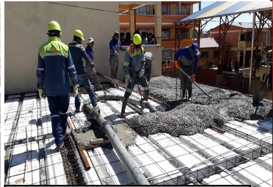
VACIADO DE LOSA CON HORMIGÓN PREMEZCLADO U.E. LA FLORIDA
