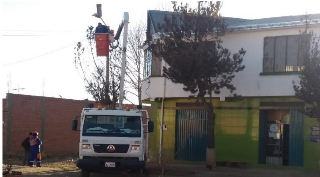
Mantenimiento de calles y avenidas Urb. Jose Ballivian "A" Distrito 6
