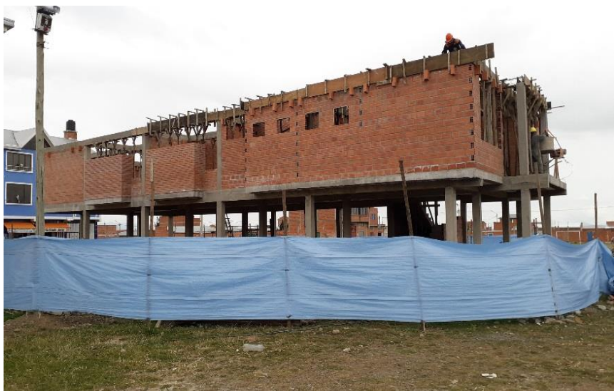
Vaciado de viga de encadenado Urb. José Ballivian DISTRITO 6
