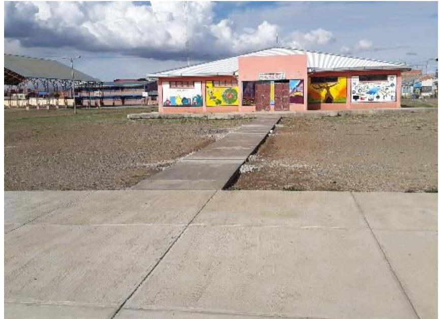
VACIADO DE ACCESOS A LABORATORIOS DE COMPUTACIÓN U.E. VILIROCO
